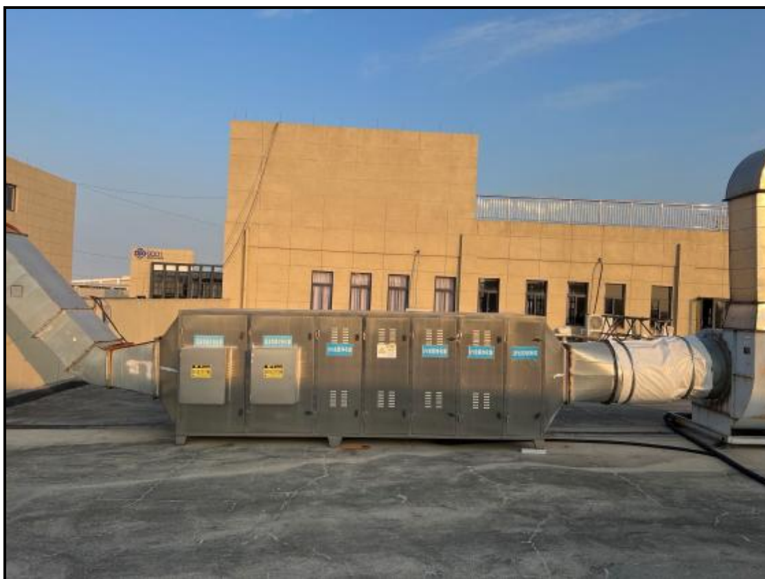
图 4-2 印刷、烘干、润版、洗车废气治理设施照片
