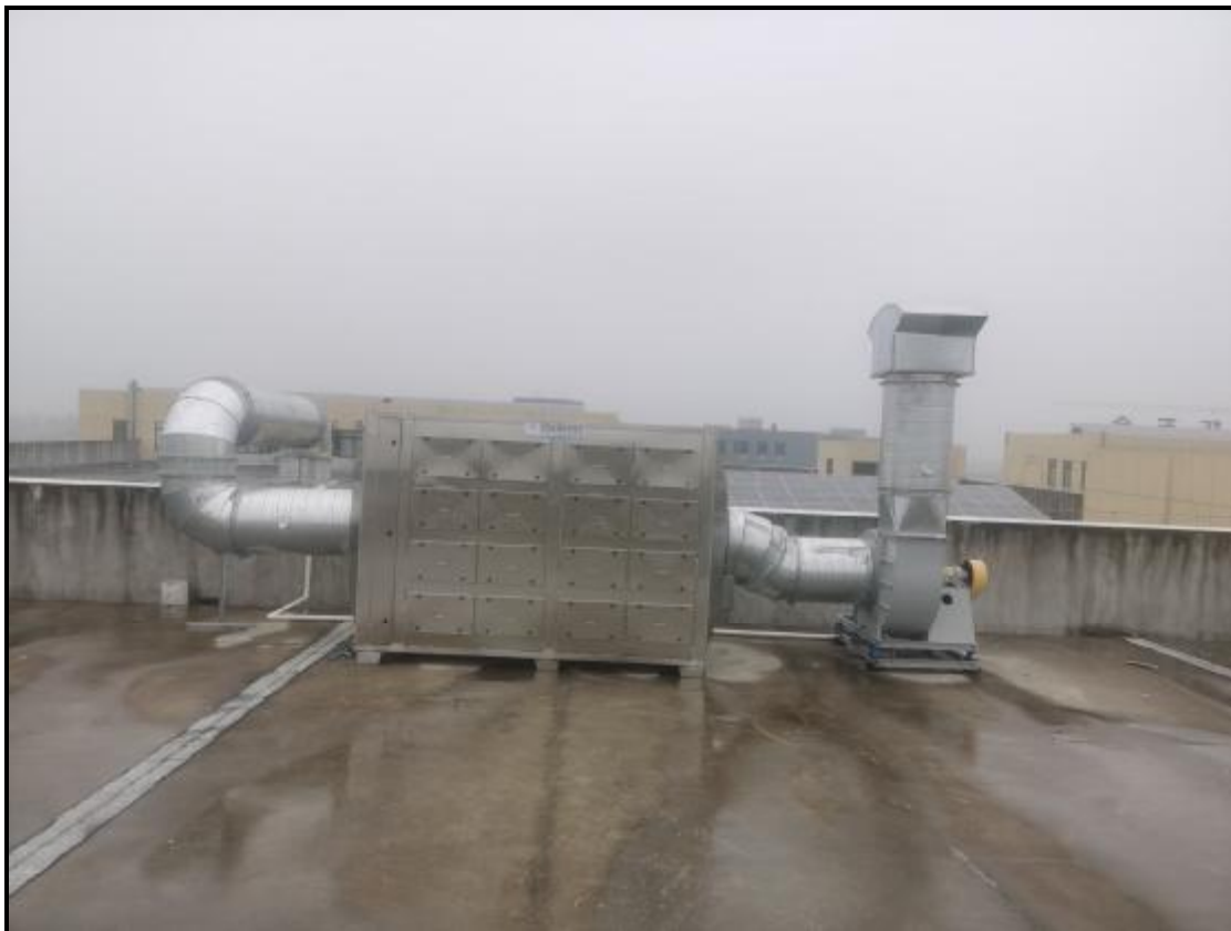
图 4-3 废气治理设施照片（活性炭吸附装置）
