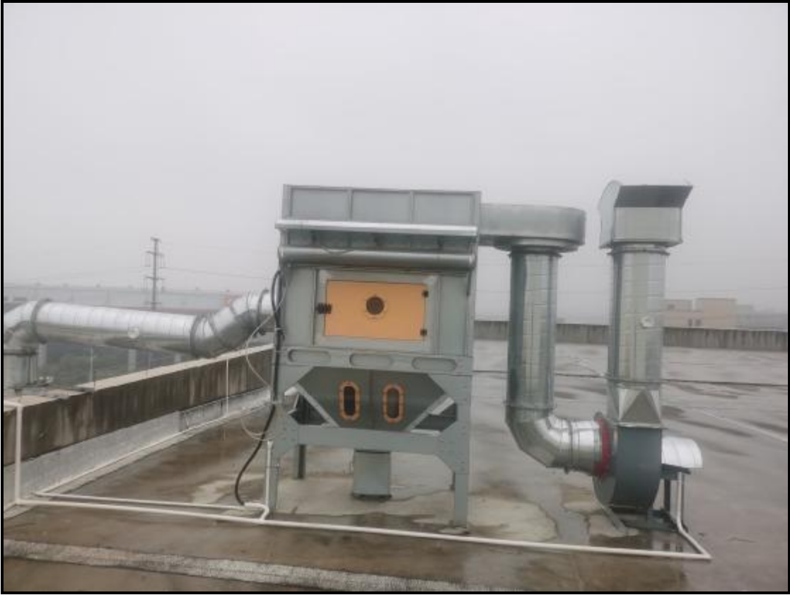
图 4-2 废气治理设施照片（布袋除尘装置）
