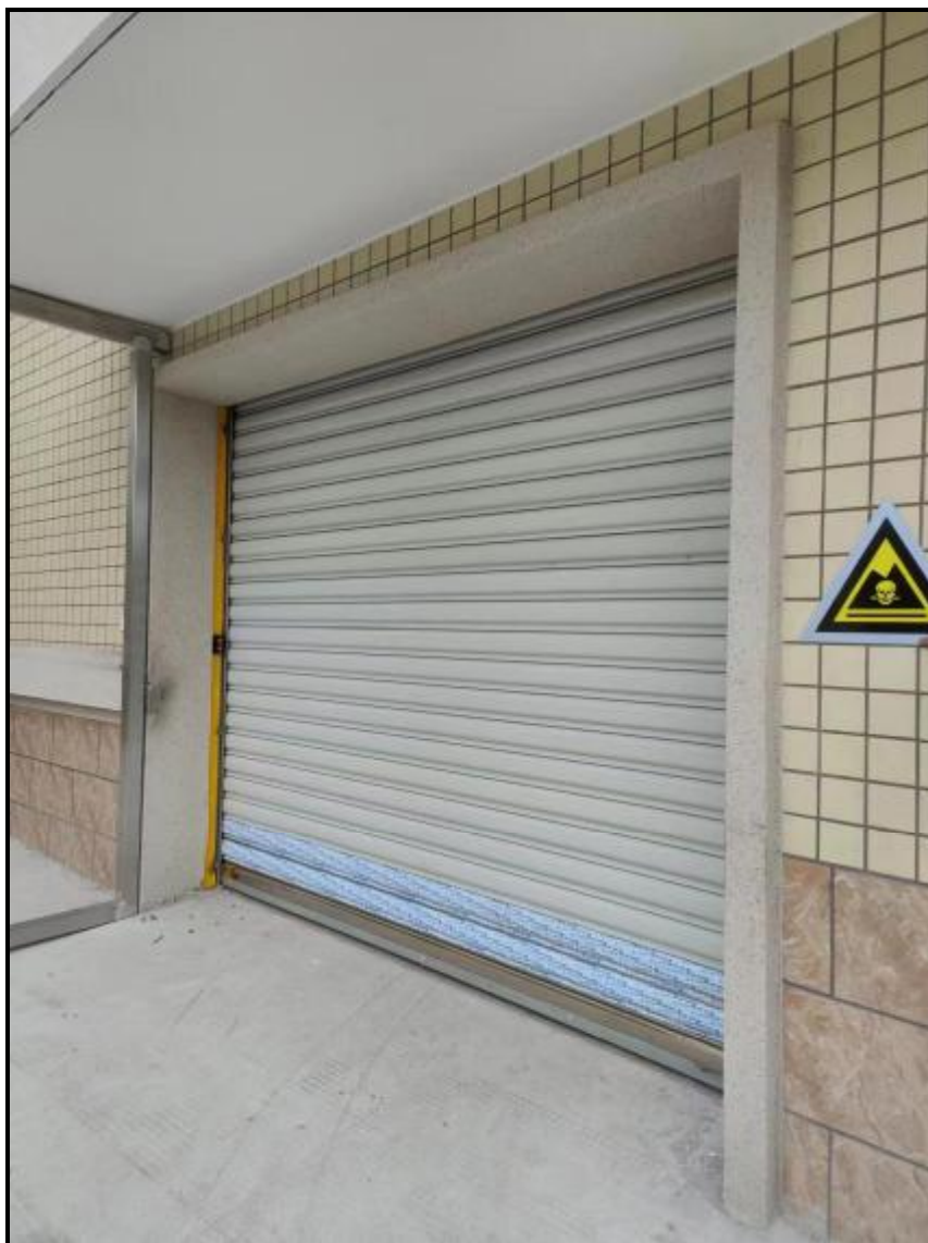
图 4-1 危废暂存场所照片
