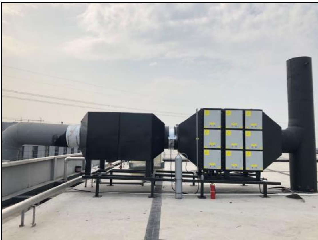
图 4-2 加弹废气治理设施照片
