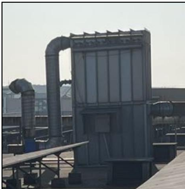
图 4-5 激光切割废气治理设施照片
