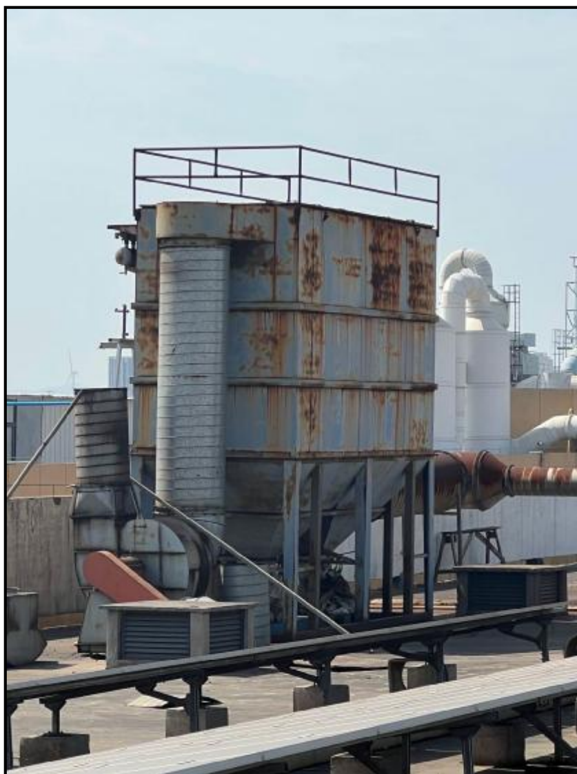
图 4-4 抛丸、焊接废气治理设施照片
