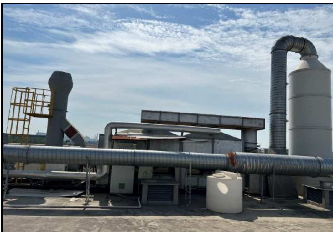
图 4-9 喷漆废气治理设施照片
