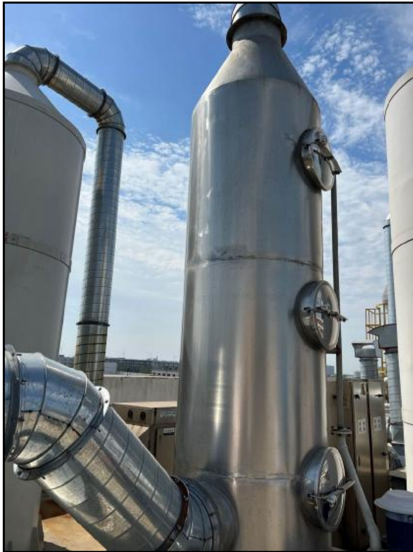
图 4-10 喷漆烘干、喷胶固化废气治理设施照片
