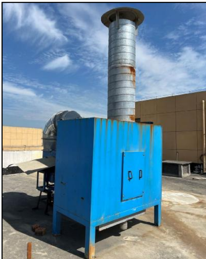
图 4-8 打磨废气治理设施照片
