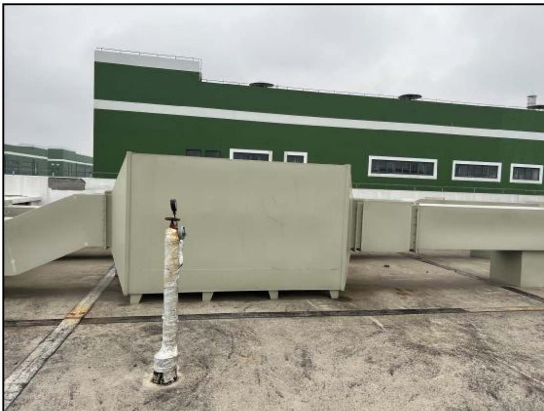
图 4-6 废气治理设施照片（活性炭吸附装置（东侧））
