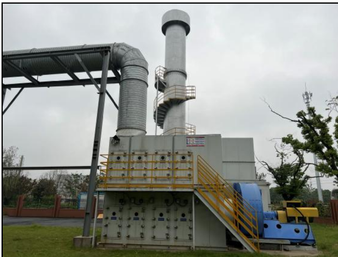
图 4-4 废气治理设施照片（沸石转轮浓缩+RTO 焚烧装置）
