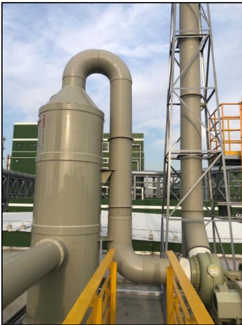
图 4-5 废气治理设施照片（碱喷淋装置）
