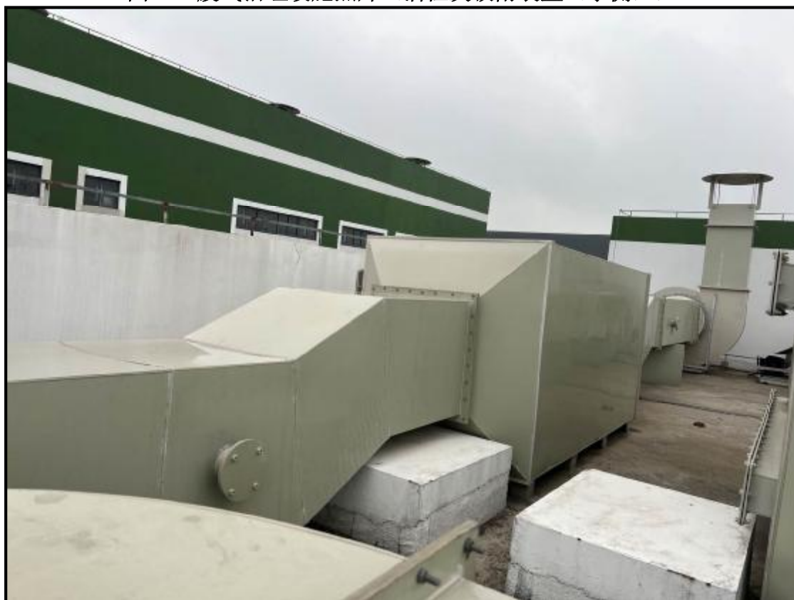
图 4-7 废气治理设施照片（活性炭吸附装置（西侧））
