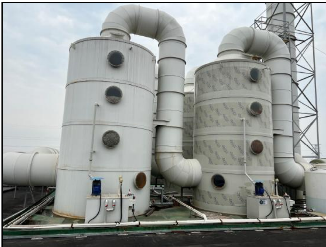
图 4-4 酸洗、盐酸储罐废气治理设施照片
