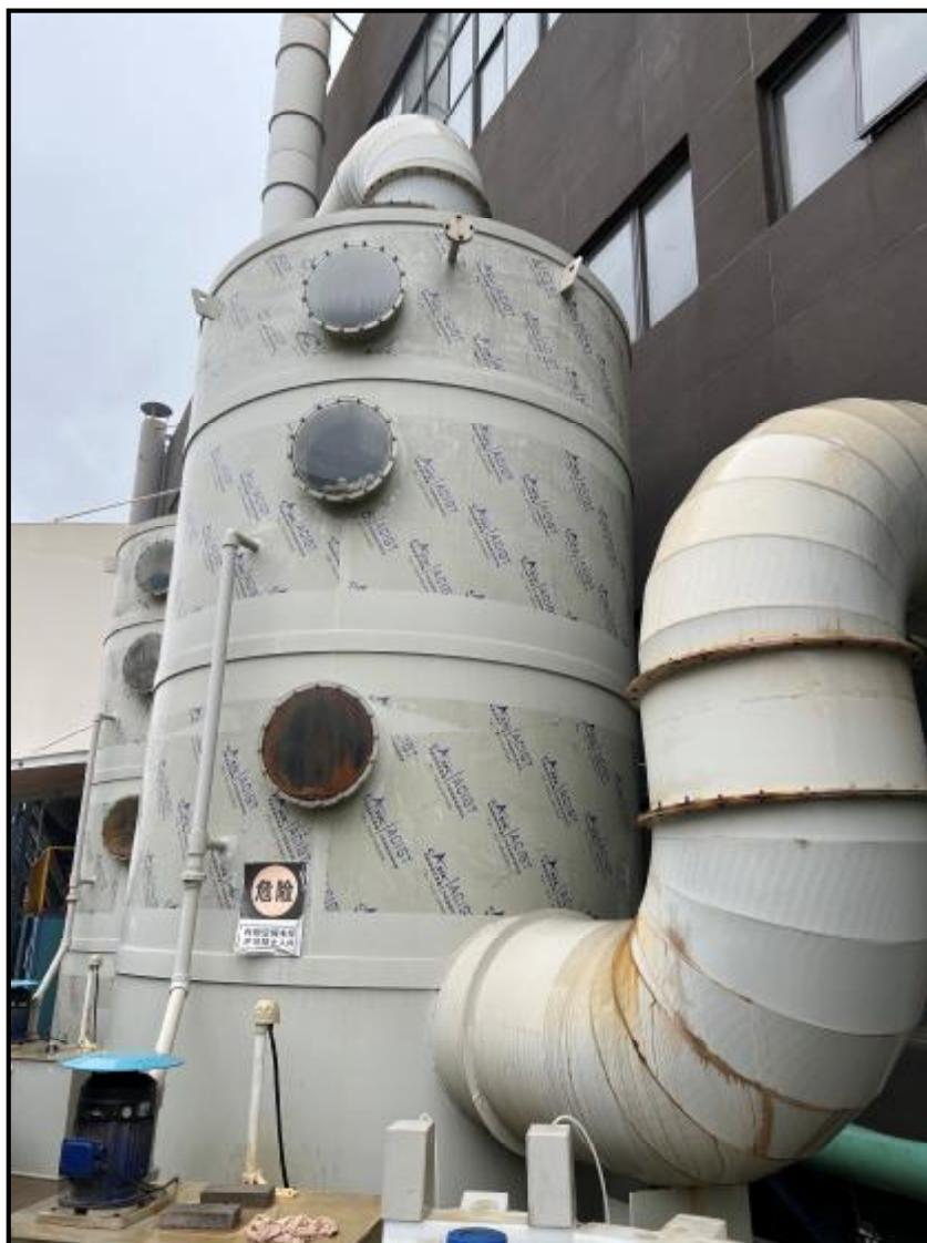
图 4-5 热镀锌前处理废气治理设施照片
