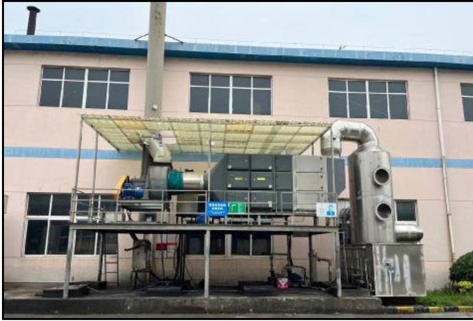
图 4-6 废气治理设施照片（热处理废气）
