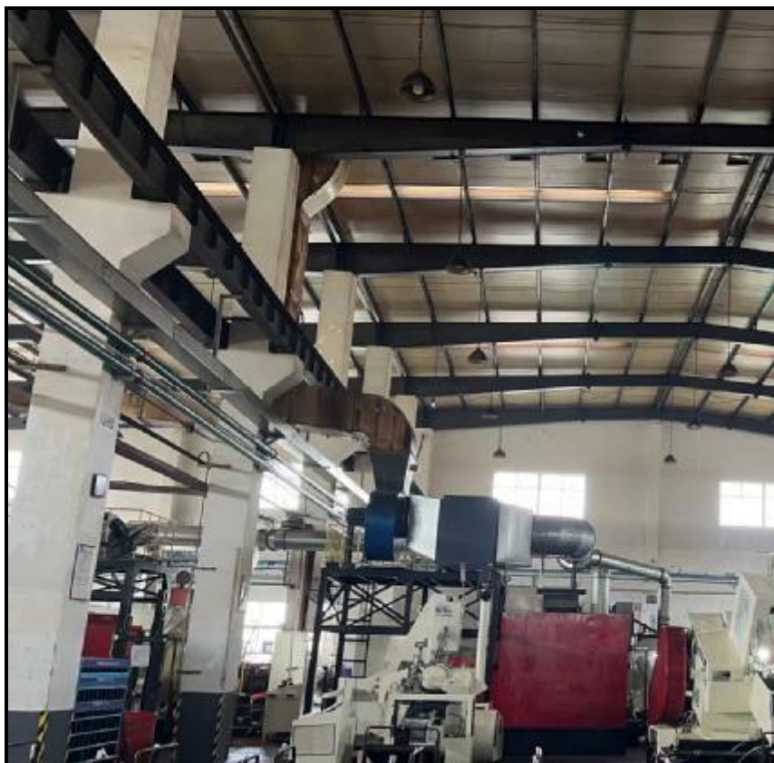
图 4-4 废气治理设施照片（2 台冷墩机废气）
