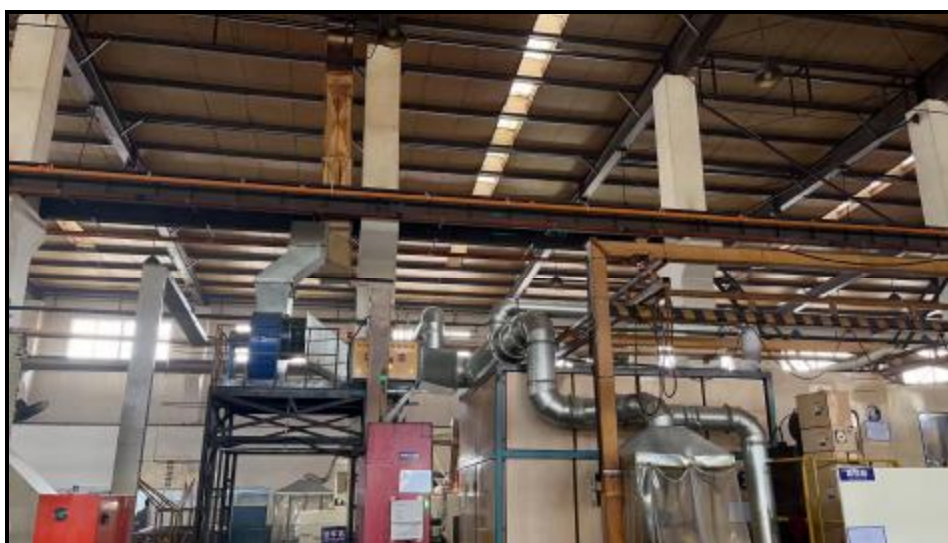
图 4-5 废气治理设施照片（3 台冷墩机废气）
