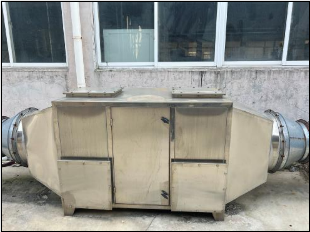
图 4-2 废气治理设施照片
