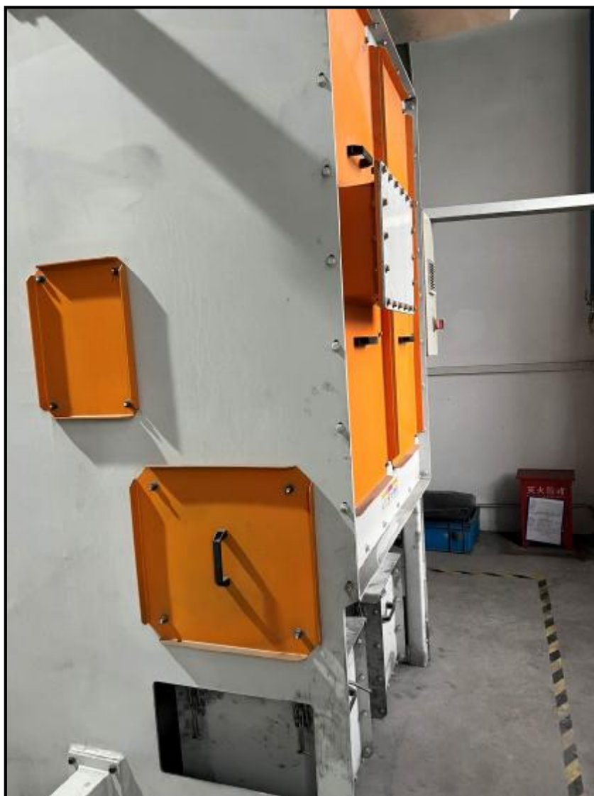
图 4-5 抛丸废气治理设施照片
