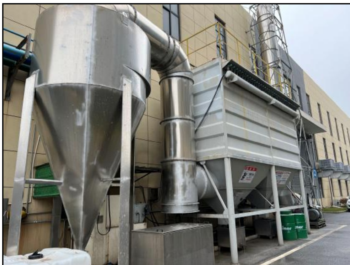
图 4-4 熔化废气治理设施照片
