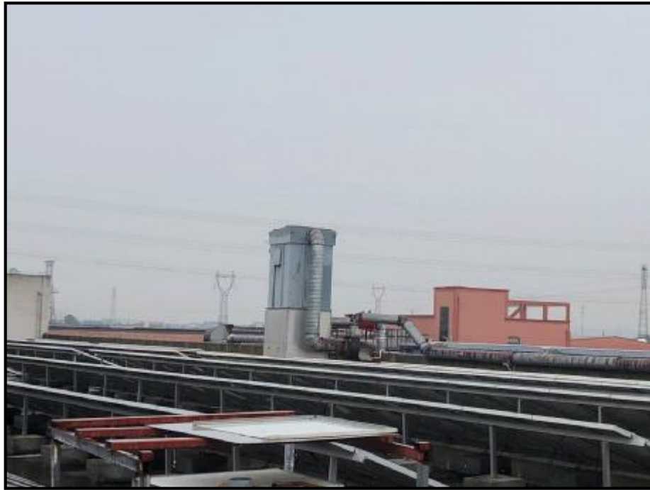
图 4-2 激光切割废气治理设施照片（布袋除尘装置）
