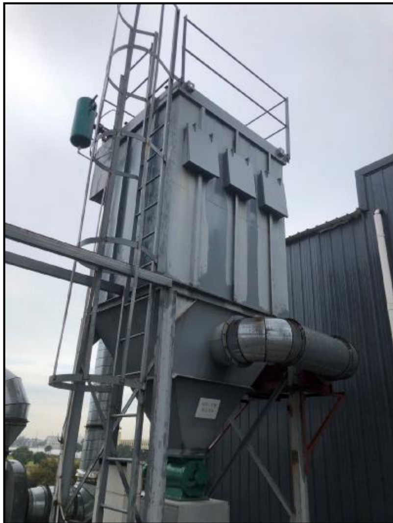
图 4-3 焊接废气治理设施照片（布袋除尘装置）
