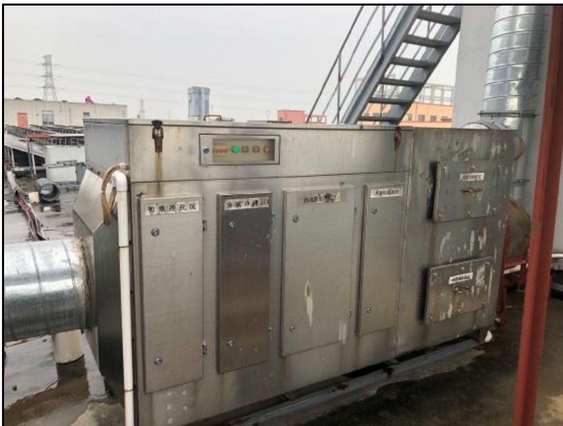
图 4-4 补漆、丝印废气治理设施照片（UV 光催化+活性炭吸附装置）
