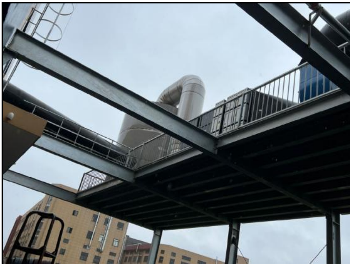
图 4-3 废气治理设施照片（滚牙废气）
