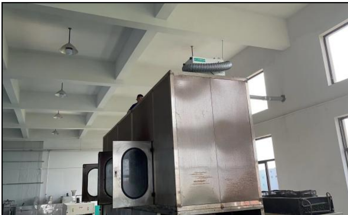
图 4-3 废气治理设施照片（清洗废气）
