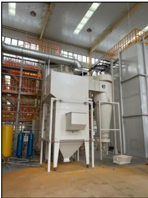
图 4-8 外喷塑废气治理设施照片 2
