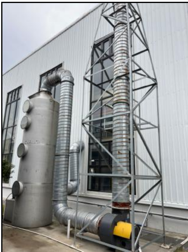
图 4-4 焊接、补锌废气治理设施照片
