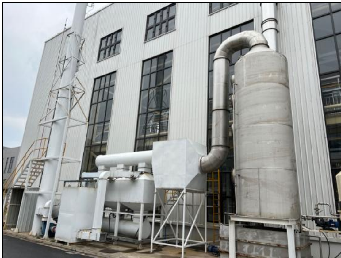
图 4-6 水性涂装、固化废气治理设施照片
