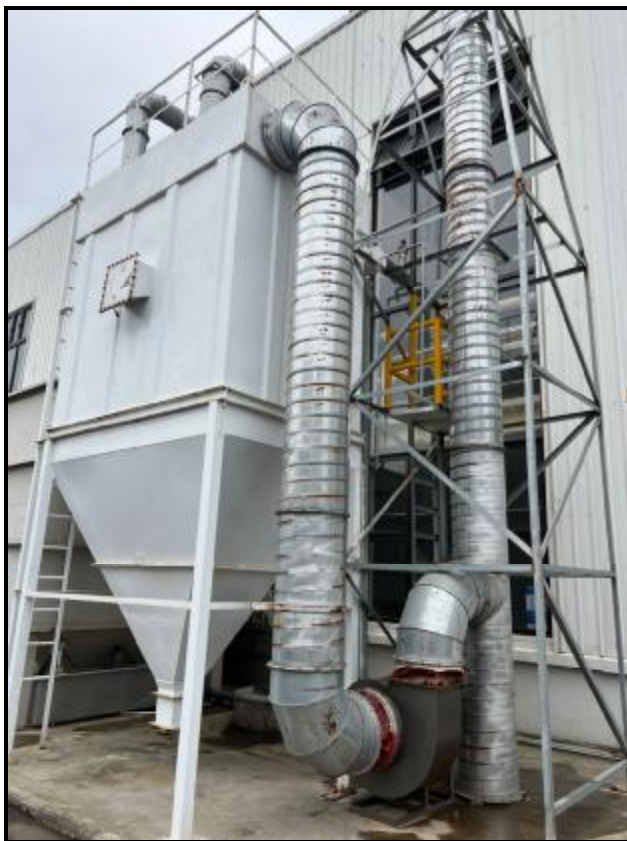
图 4-5 内喷塑废气治理设施照片
