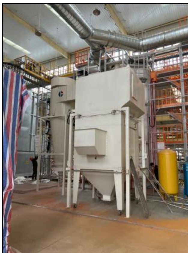
图 4-7 外喷塑废气治理设施照片 1
