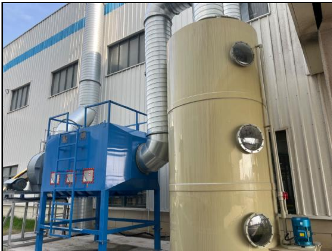
图 4-5 废气治理设施照片（胶印、预印、上光）
