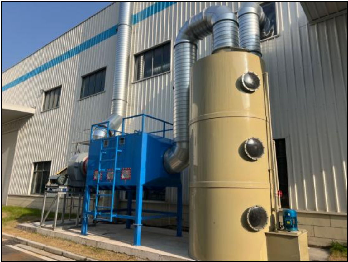
图 4-4 废气治理设施照片（水性油墨印刷）
