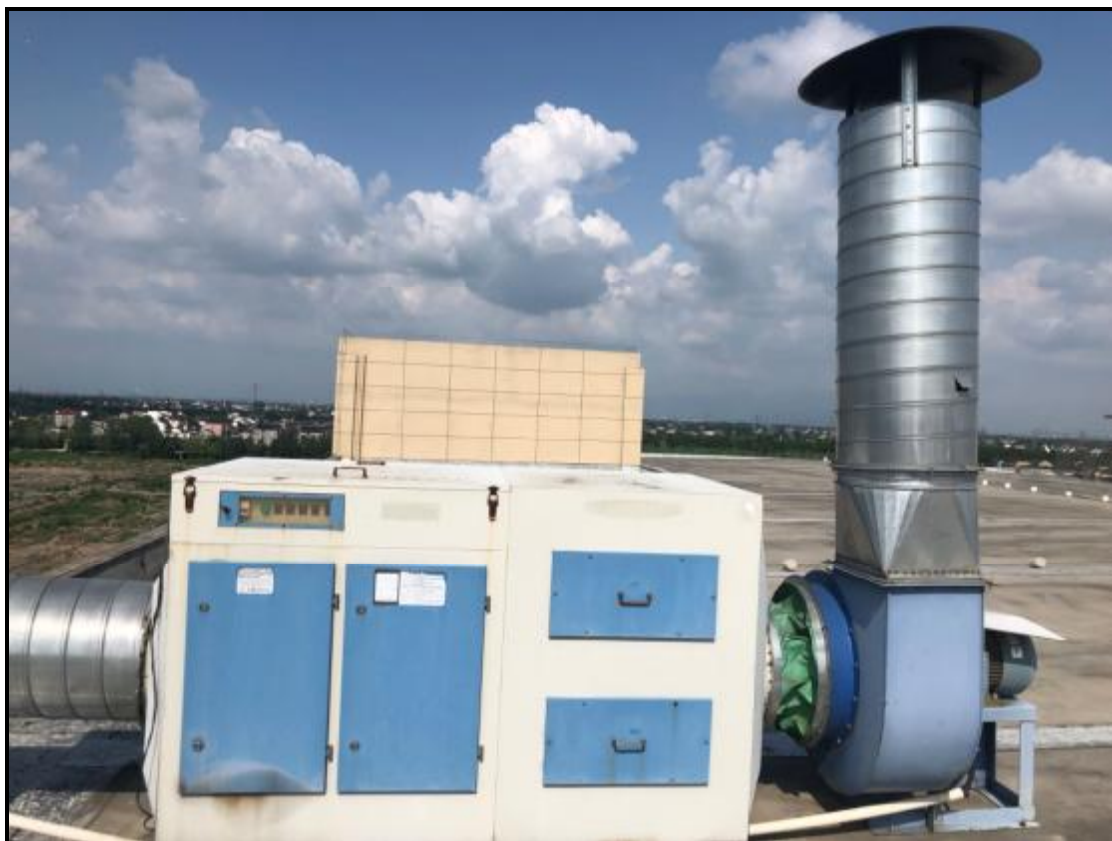
图 4-6 废气治理设施照片（挤出废气）
