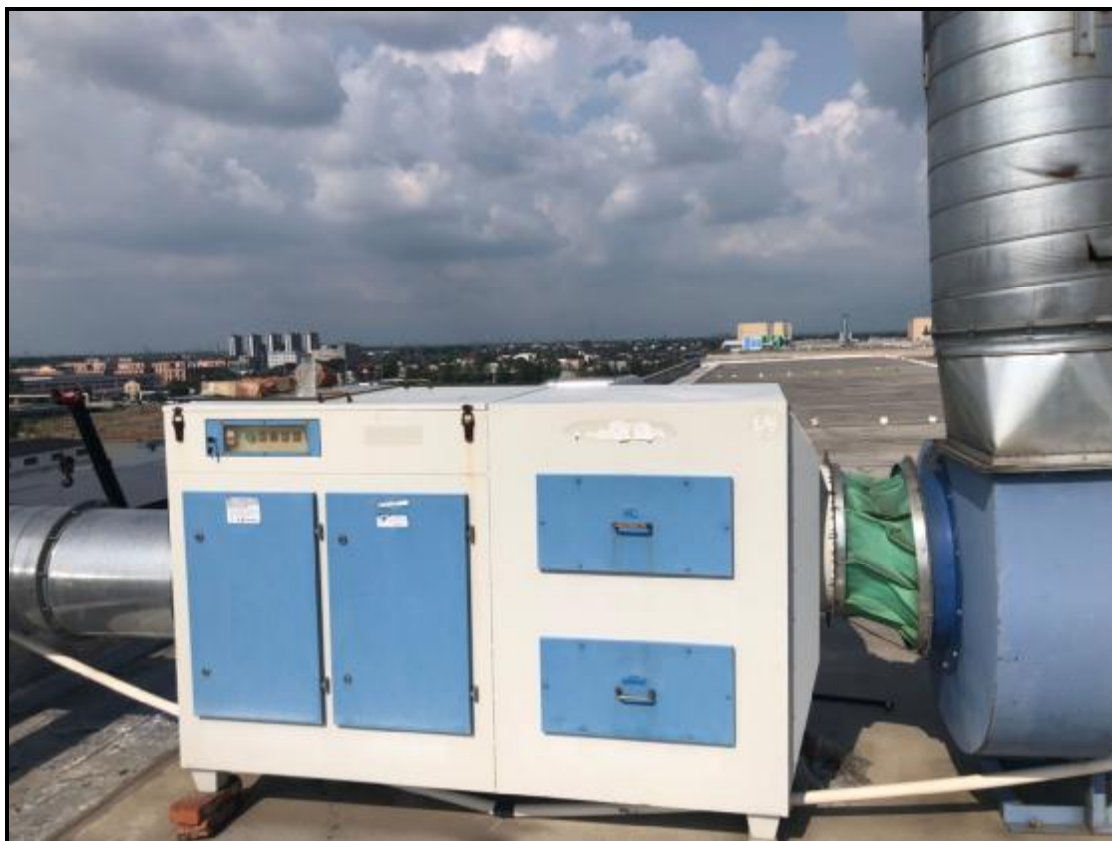
图 4-2 废气治理设施照片（印刷、烘干废气）
