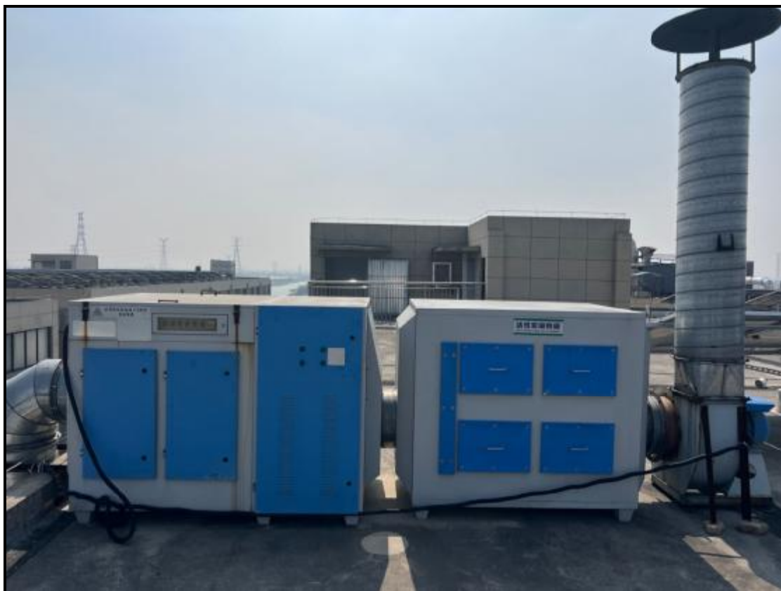
图 4-4 废气治理设施照片（B2 一楼注塑废气）
