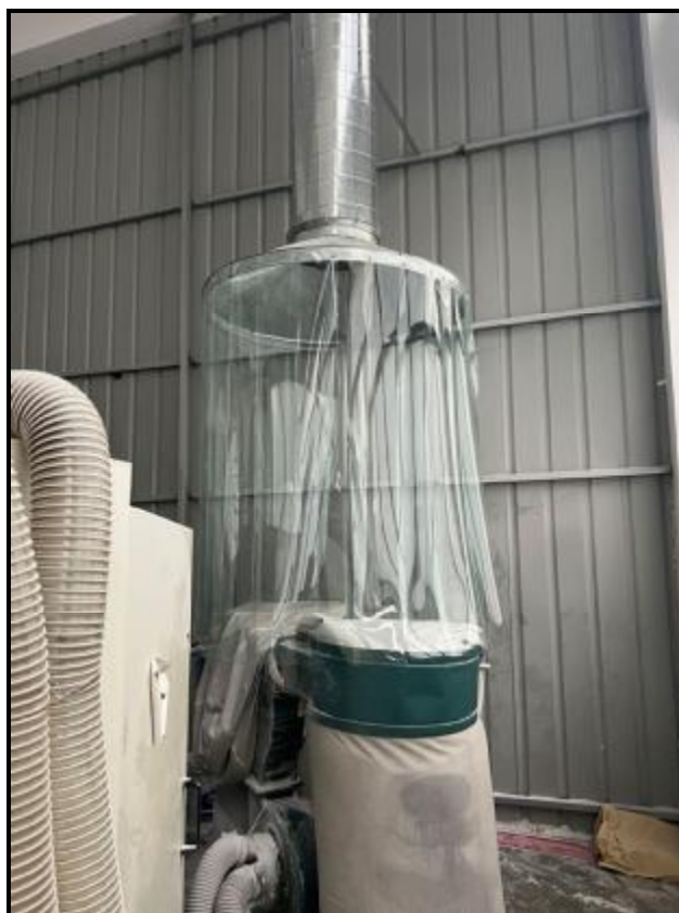
图 4-7 废气治理设施照片（切割废气）
