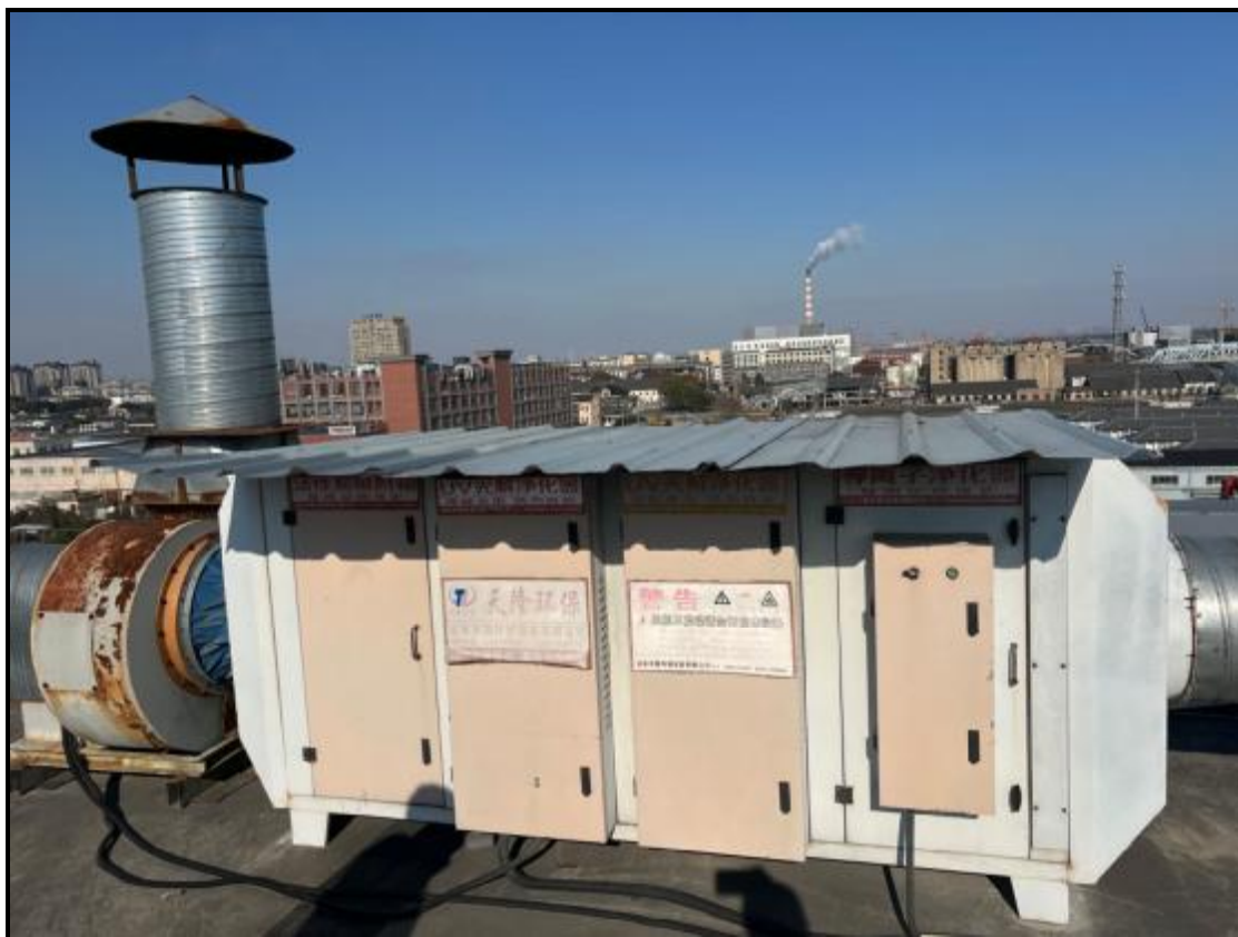
图 4-3 废气治理设施照片（B1 一楼注塑废气）
