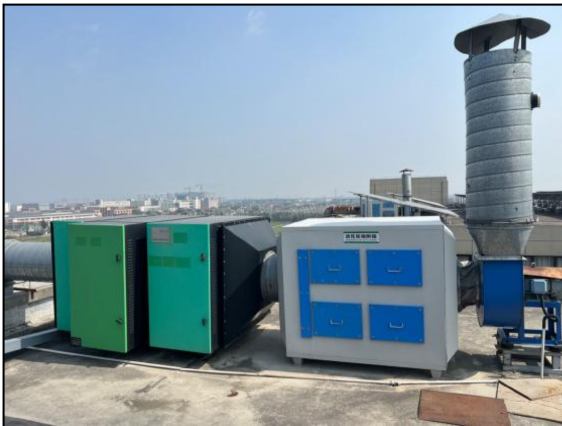
图 4-5 废气治理设施照片（B2 三楼注塑废气）
