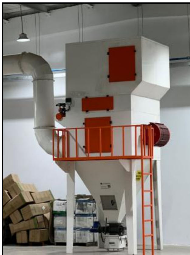
图 4-5 废气治理设施照片（喷塑废气）
