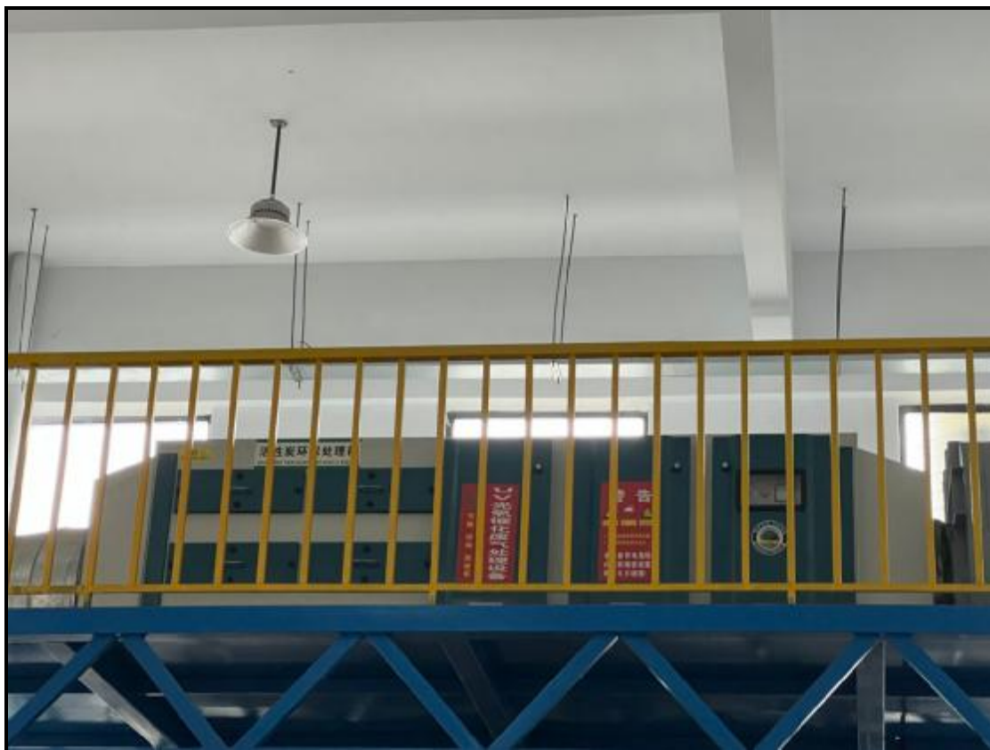
图 4-7 废气治理设施照片（喷漆废气）
