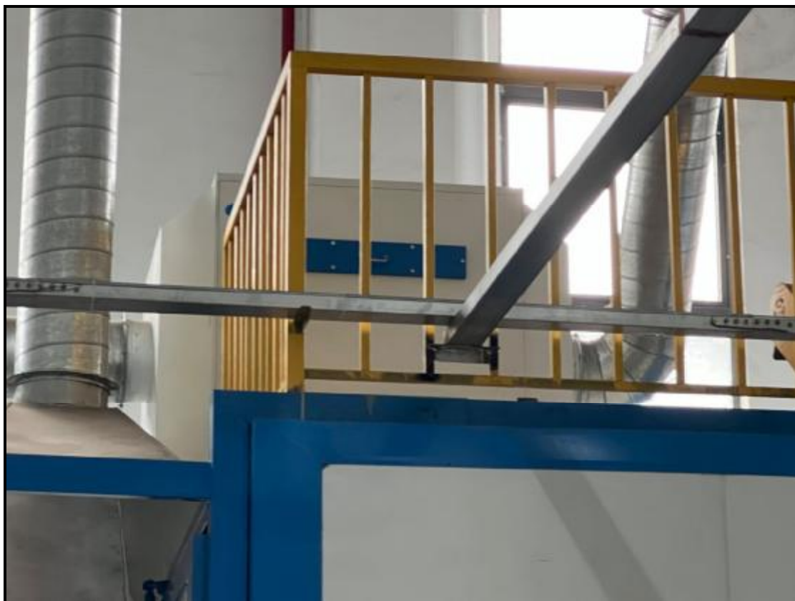
图 4-6 废气治理设施照片（烘干废气）
