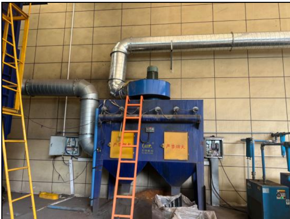
图 4-4 废气治理设施照片（抛丸废气）
