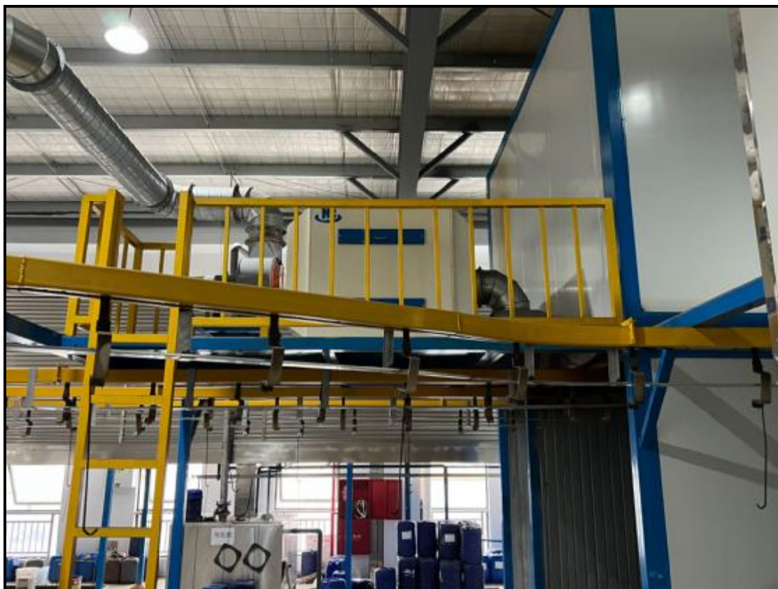
图 4-8 废气治理设施照片（固化废气）
