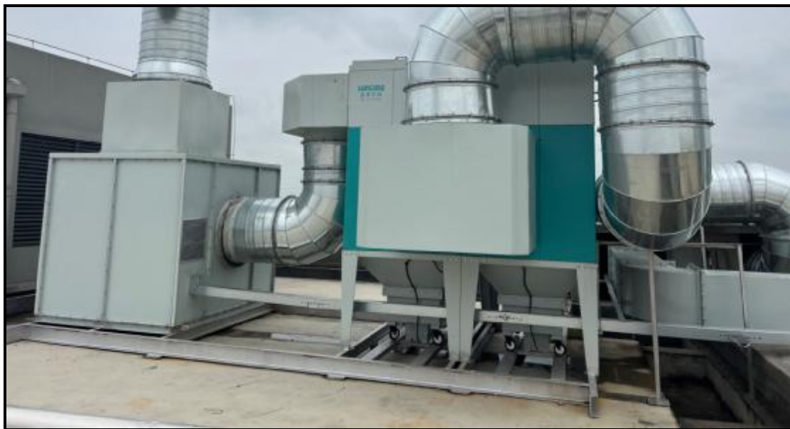
图 4-4 废气治理设施照片（布袋除尘装置）
