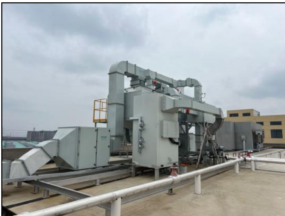
图 4-5 废气治理设施照片（过滤+活性炭吸附脱附+催化燃烧装置）
