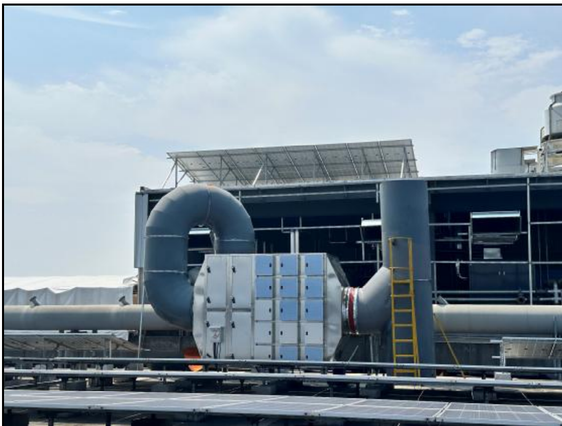
图 4-3 废气治理设施照片（车间二楼加弹废气）
