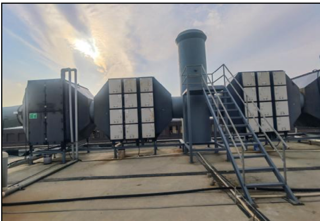
图 4-2 废气治理设施照片（车间三楼加弹废气）
