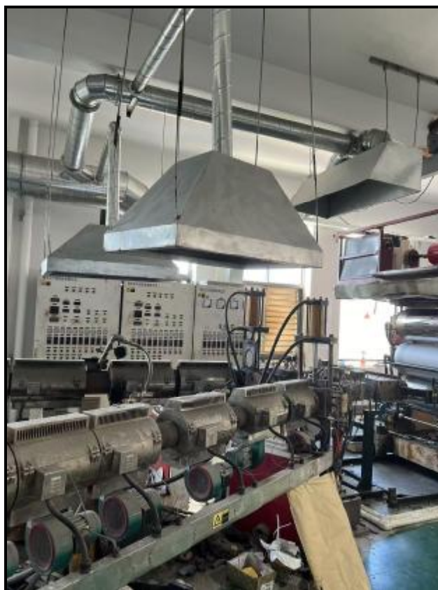
图 4-3 废气收集设施照片（抽板、真空泵废气）
