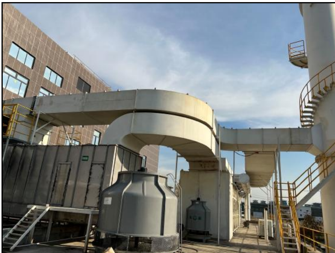
图 4-3 调漆、喷漆、烘干、擦拭、燃烧废气治理设施照片 (水喷淋+过滤棉+活性炭吸附脱附+RTO 焚烧装置)
