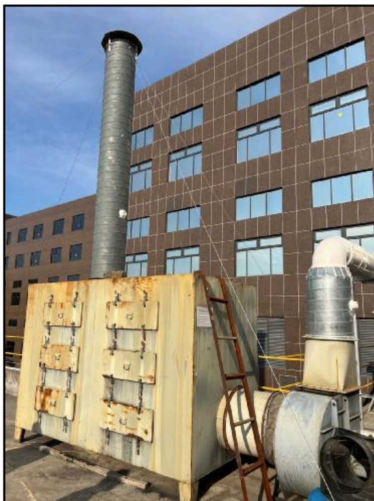
图 4-2 注塑、二次烘干废气治理设施照片（活性炭吸附装置）
