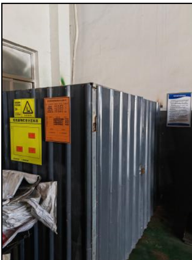
图 4-4 危废暂存场所照片（外部）
