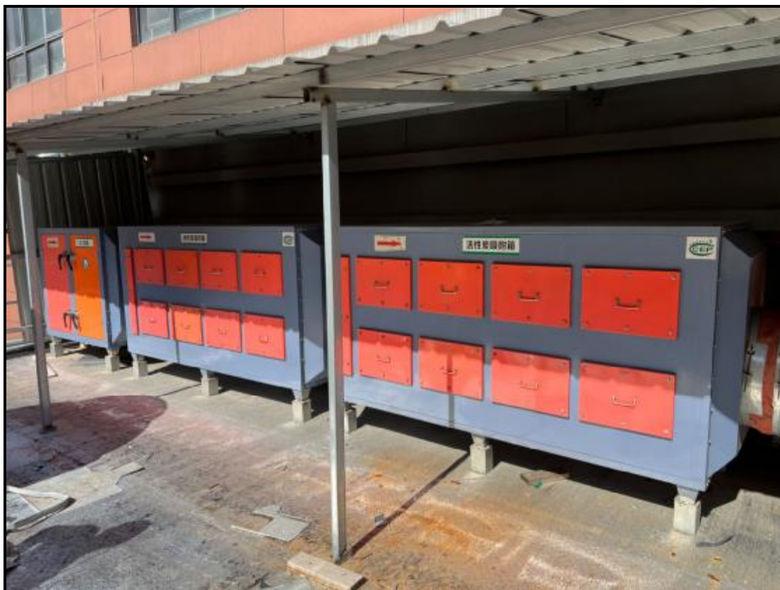
图 4-2 废气治理设施照片
