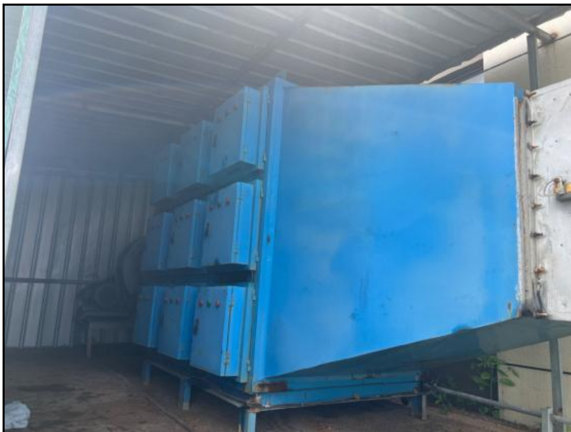
图 4-2 废气治理设施照片
