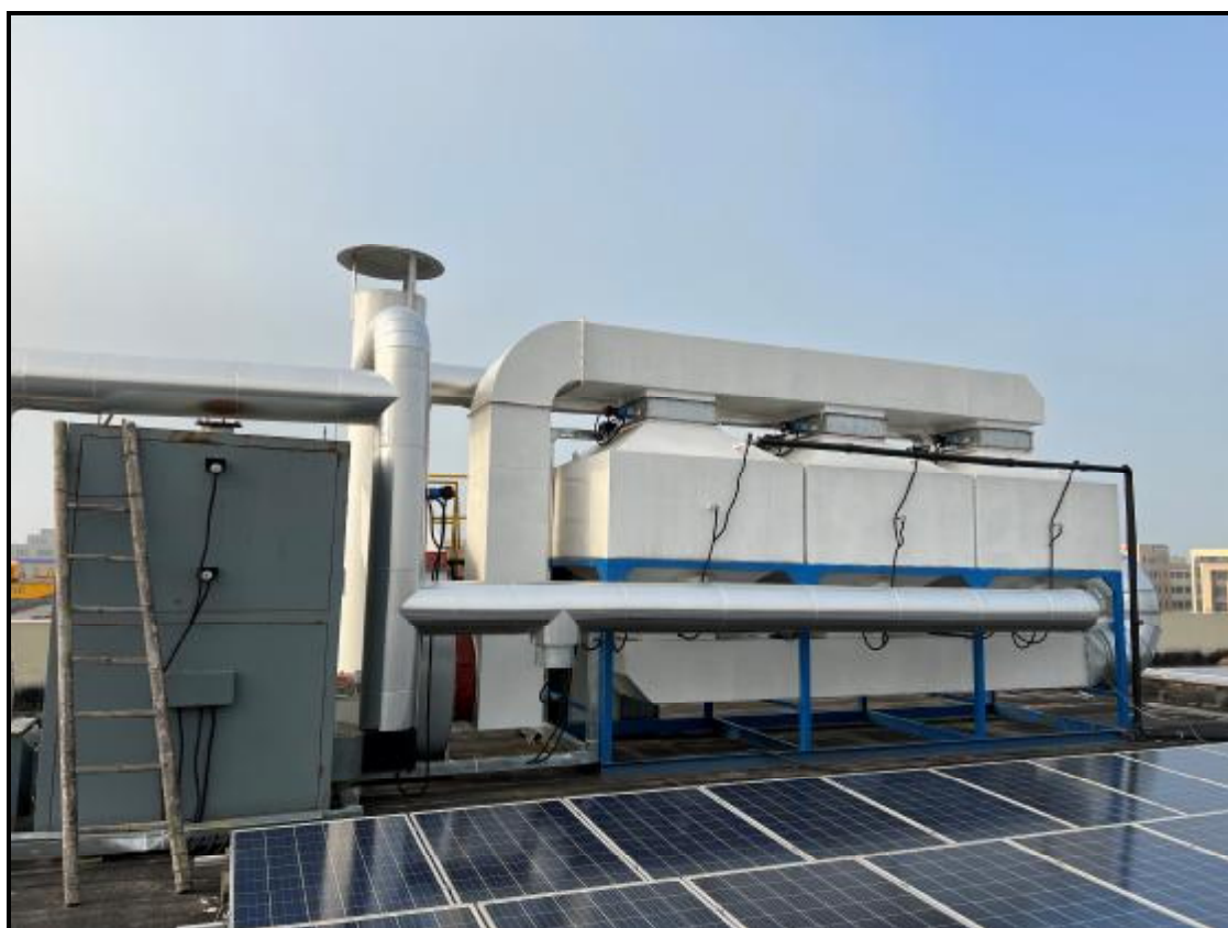
图 4-4 废气治理设施照片（北侧）
