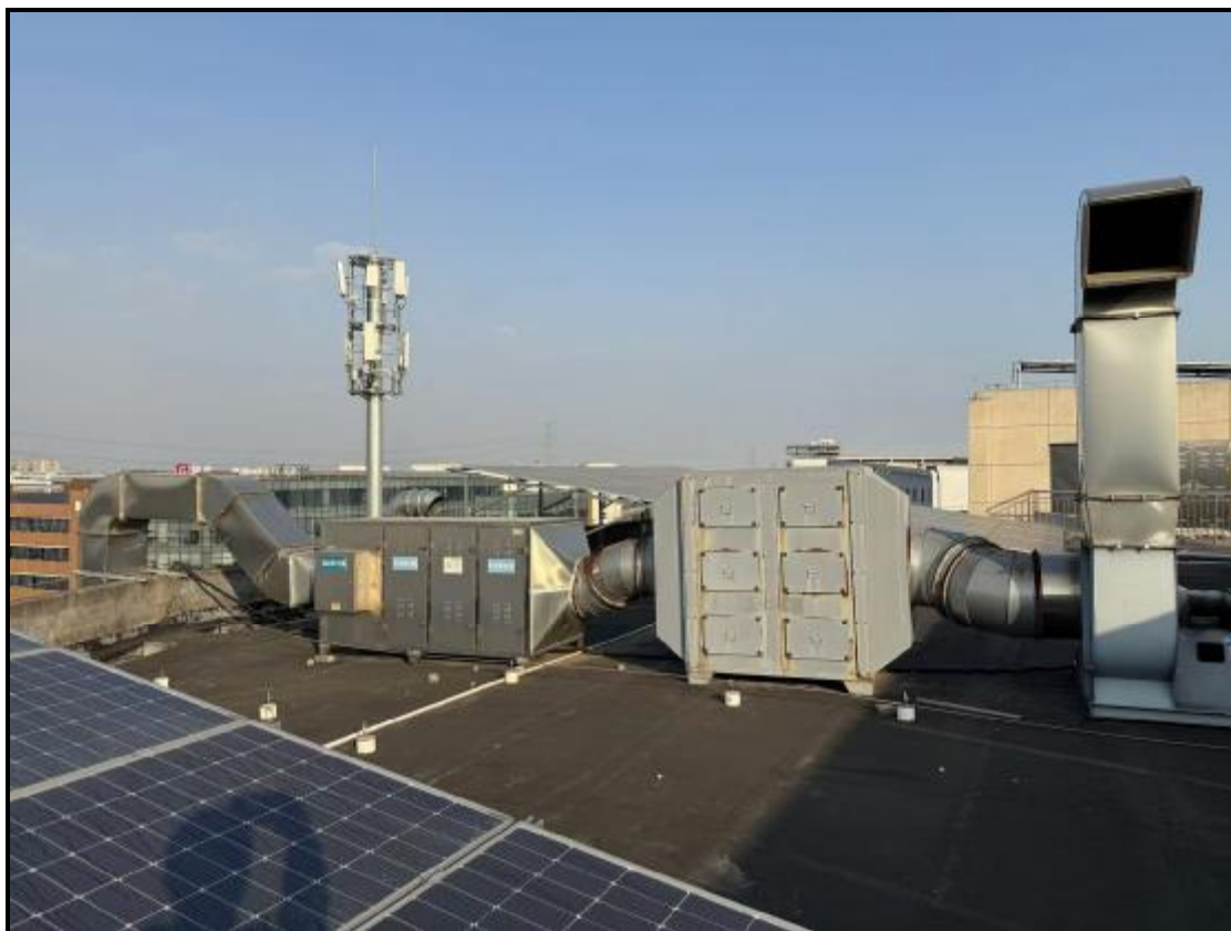
图 4-2 废气治理设施照片
