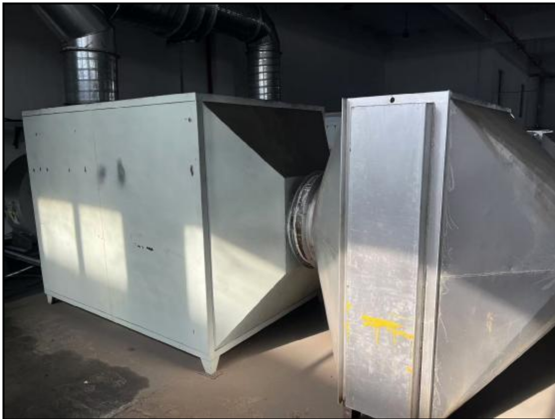
图 4-3 废气治理设施照片（西车间涂覆生产线 2 废气）
