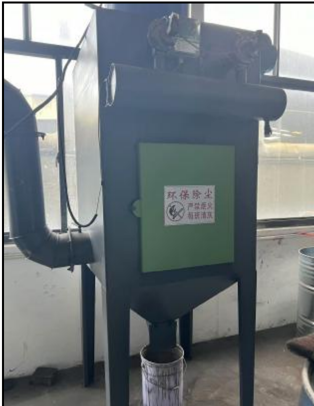
图 4-7 废气治理设施照片（喷砂废气 2）
