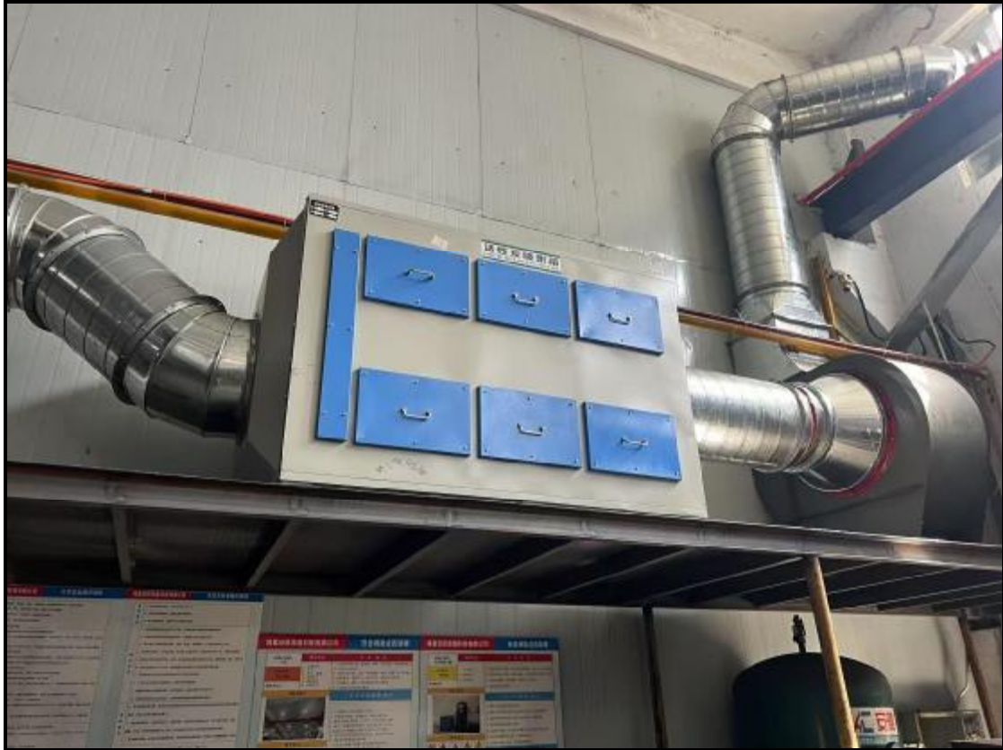
图 4-8 废气治理设施照片（原料间废气）
