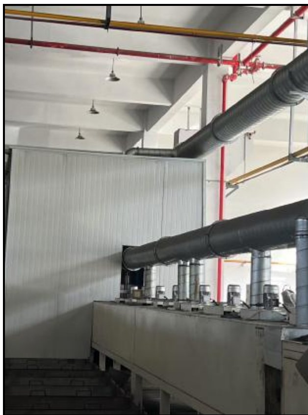
图 4-11 废气收集设施照片 3
