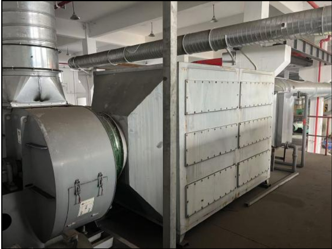
图 4-4 废气治理设施照片（西车间涂覆生产线 3 废气）
