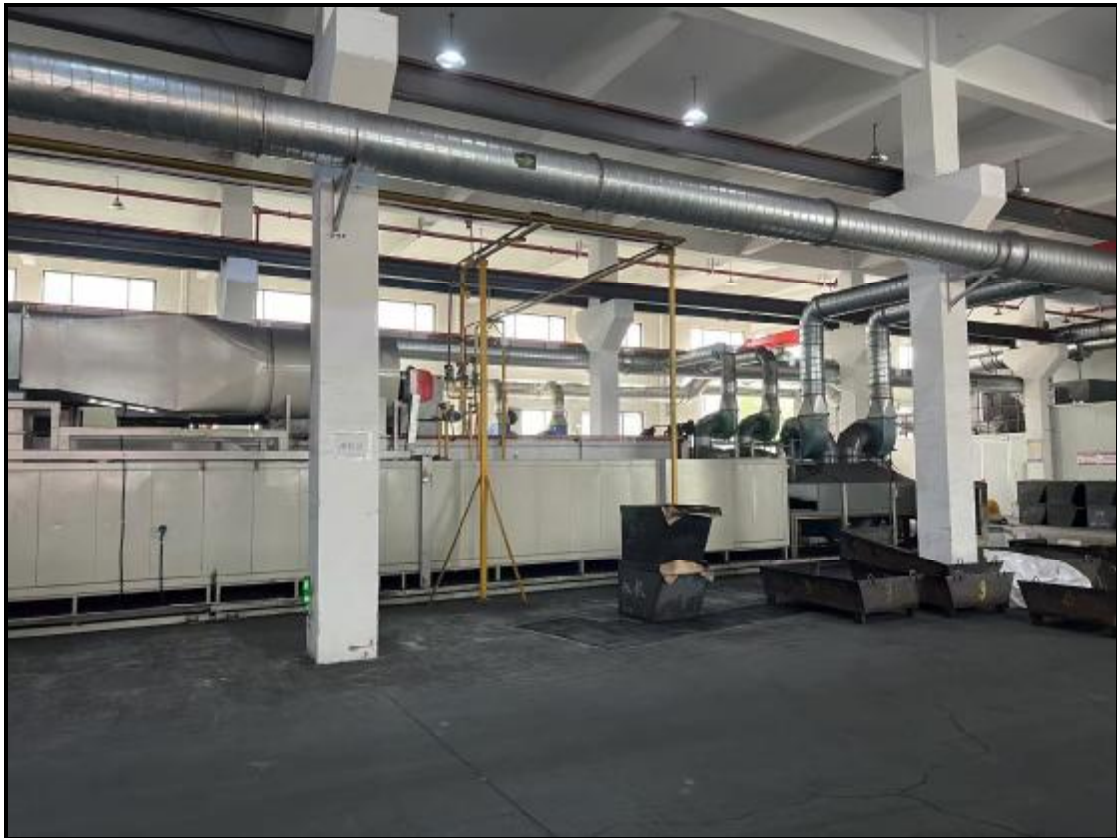
图 4-9 废气收集设施照片 1
