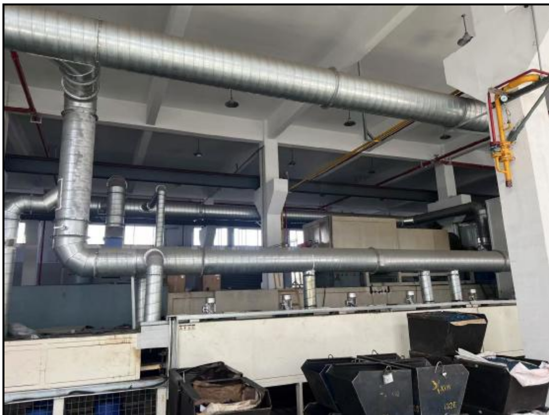
图 4-10 废气收集设施照片 2
