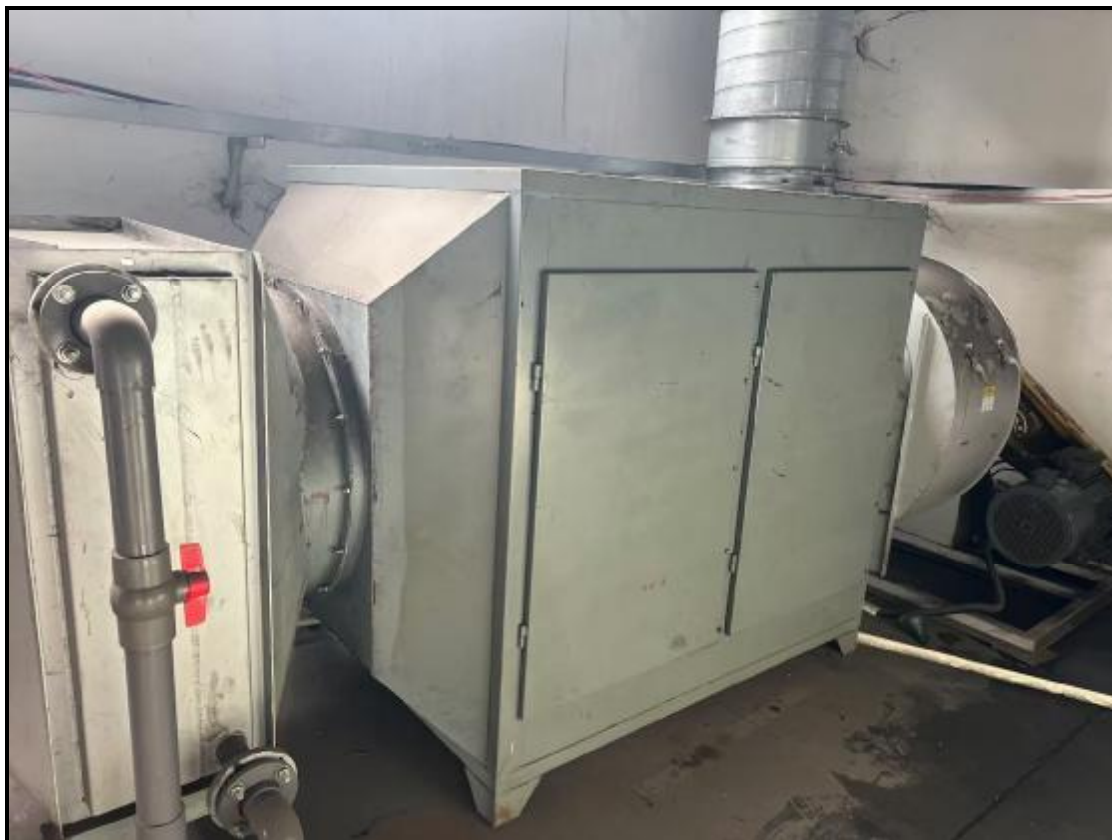
图 4-2 废气治理设施照片（西车间涂覆生产线 1 废气）
