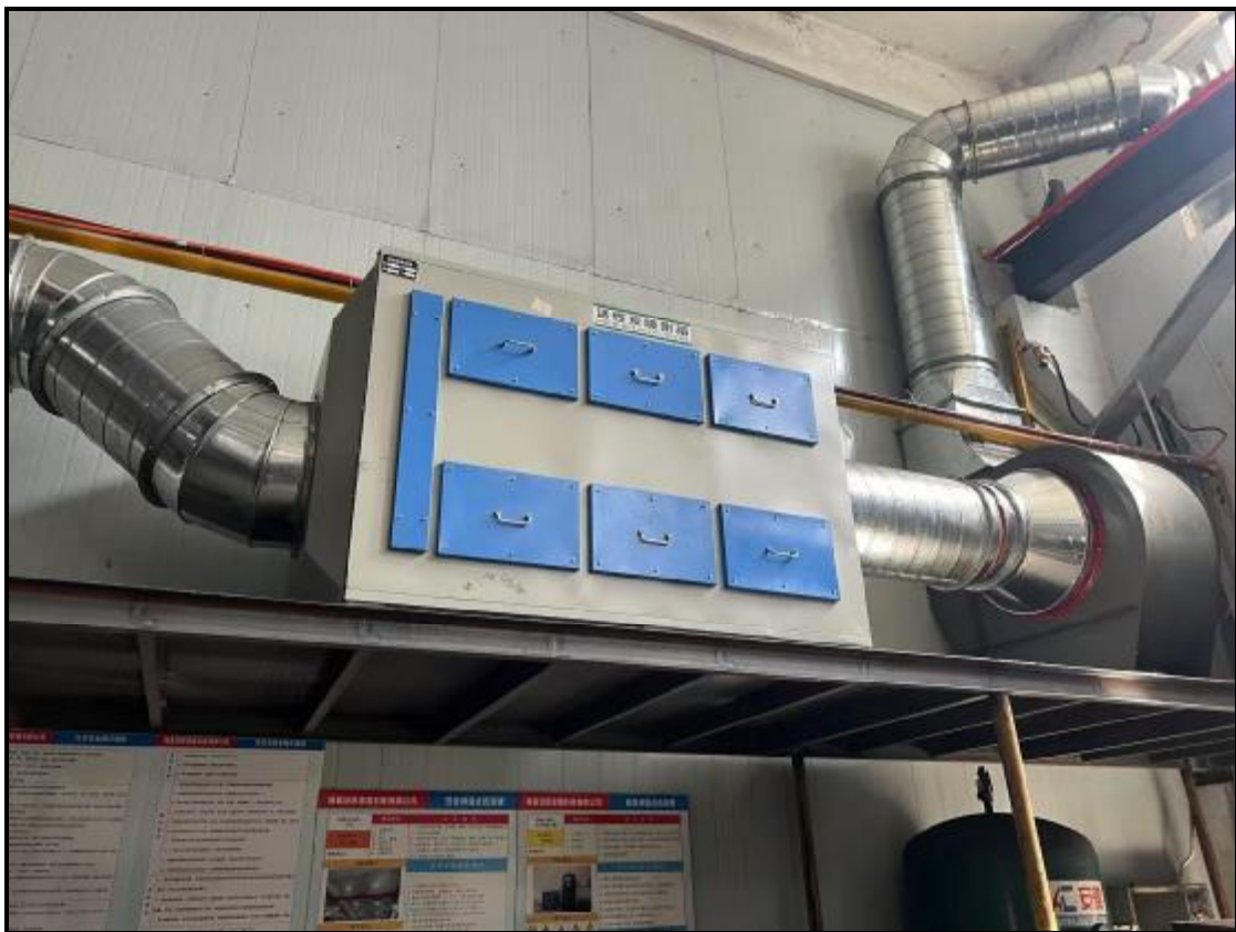
图 4-5 废气治理设施照片（东车间涂覆生产线、喷漆、烘干废气）
