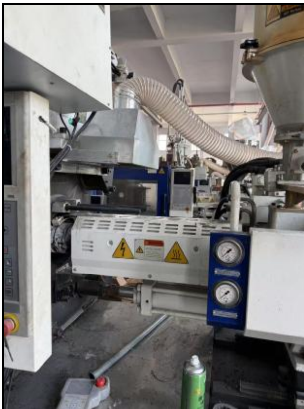
图 4-3 废气收集设施照片
