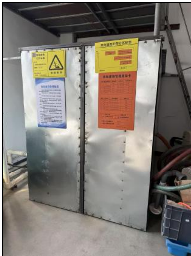
图 4-4 危废暂存场所照片（外部）
