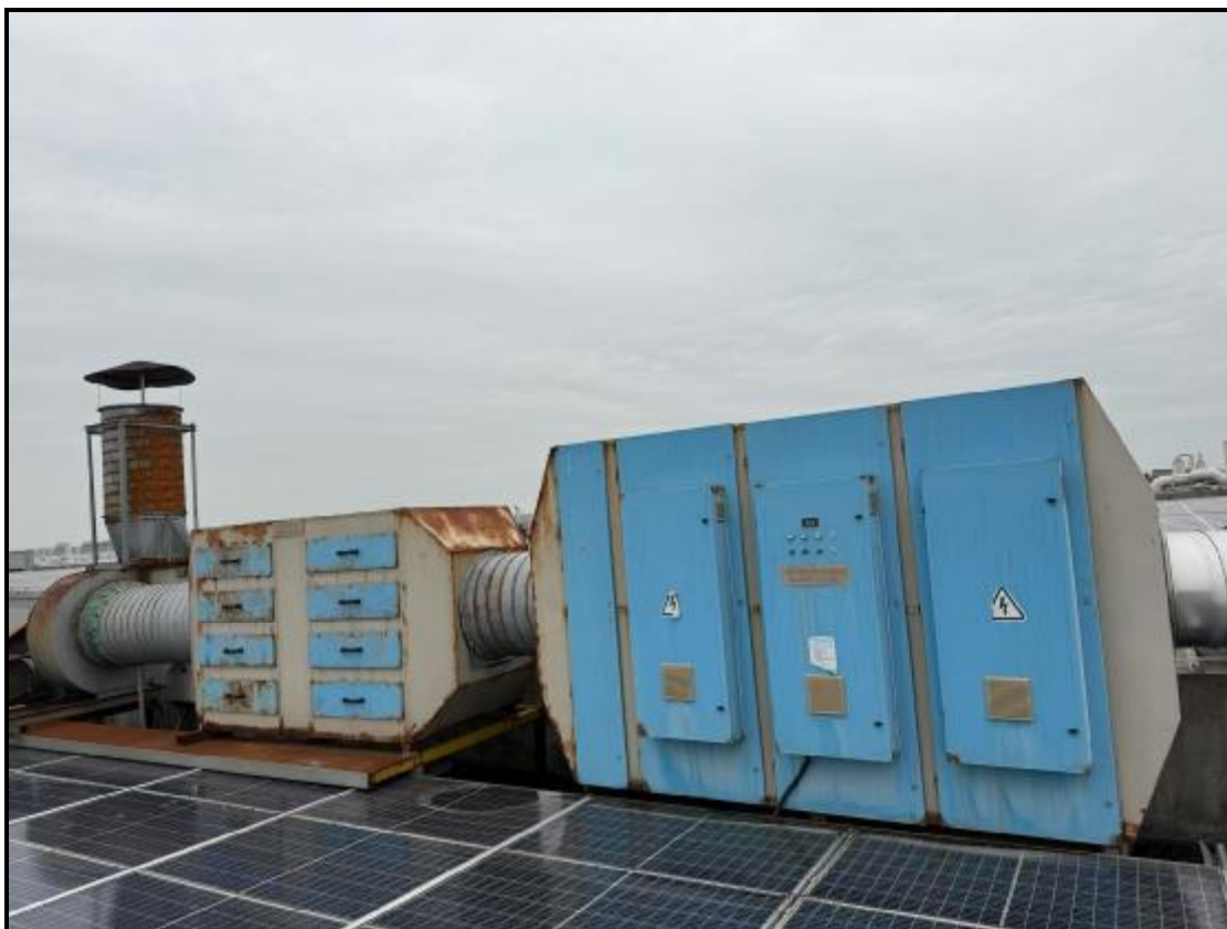
图 4-7 废气治理设施照片（造粒、挤片废气）
