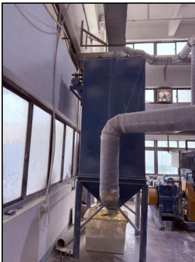
图 4-4 废气治理设施照片（投料、混料、密炼粉尘1）
