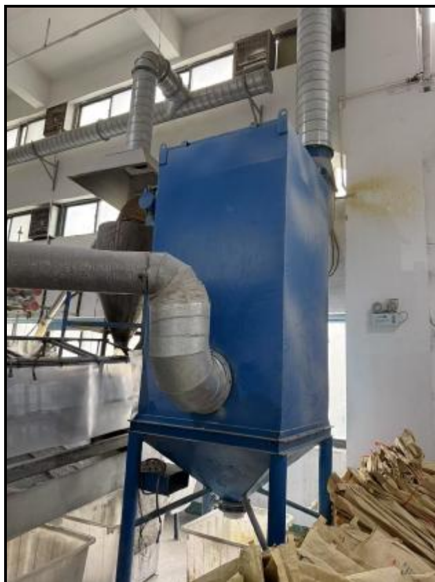
图 4-5 废气治理设施照片（投料、混料、密炼粉尘 2）
