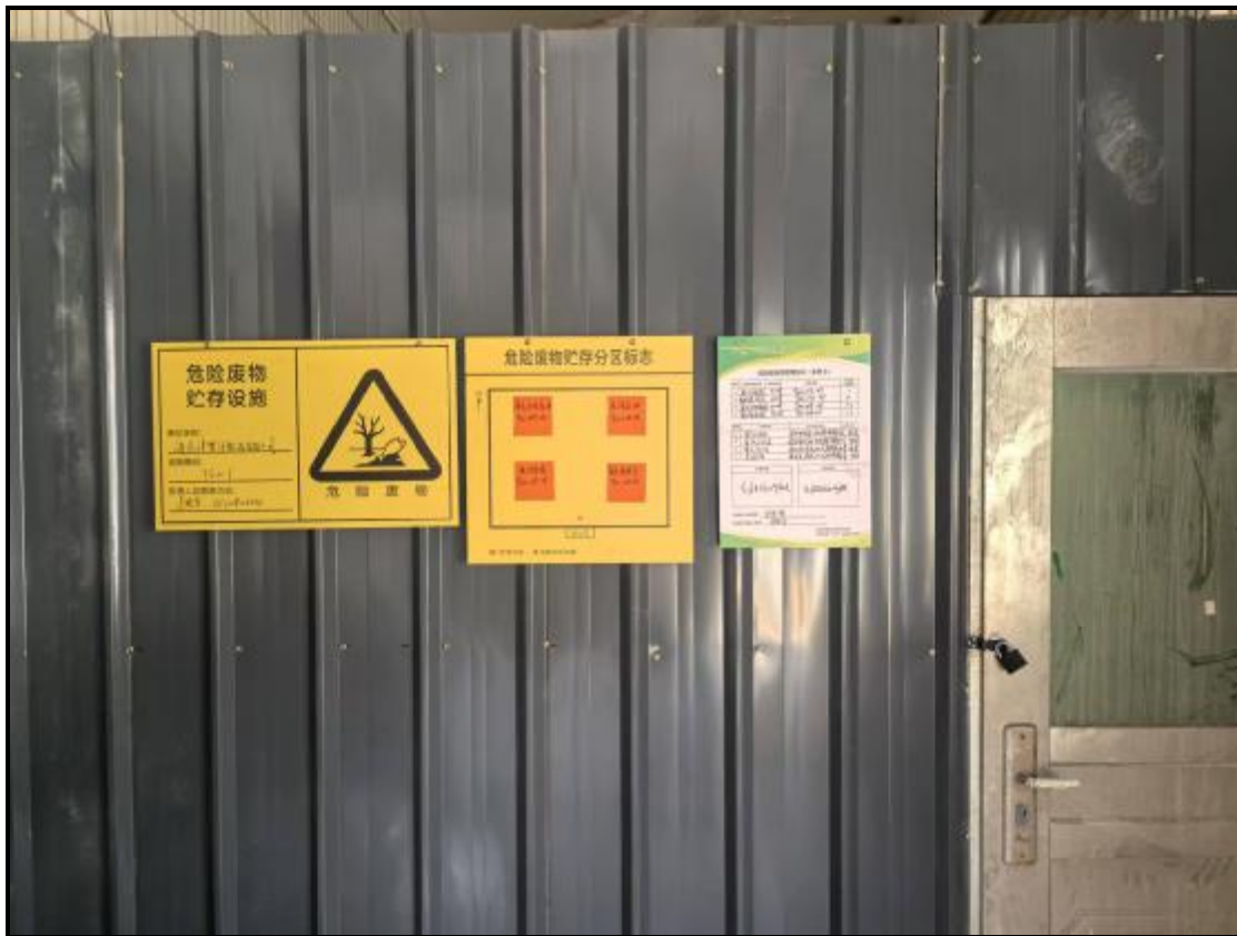
图 4-4 危废暂存场所照片（外部）
