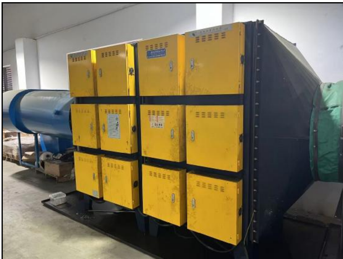
图 4-4 废气治理设施照片（静电除油装置（北侧））
