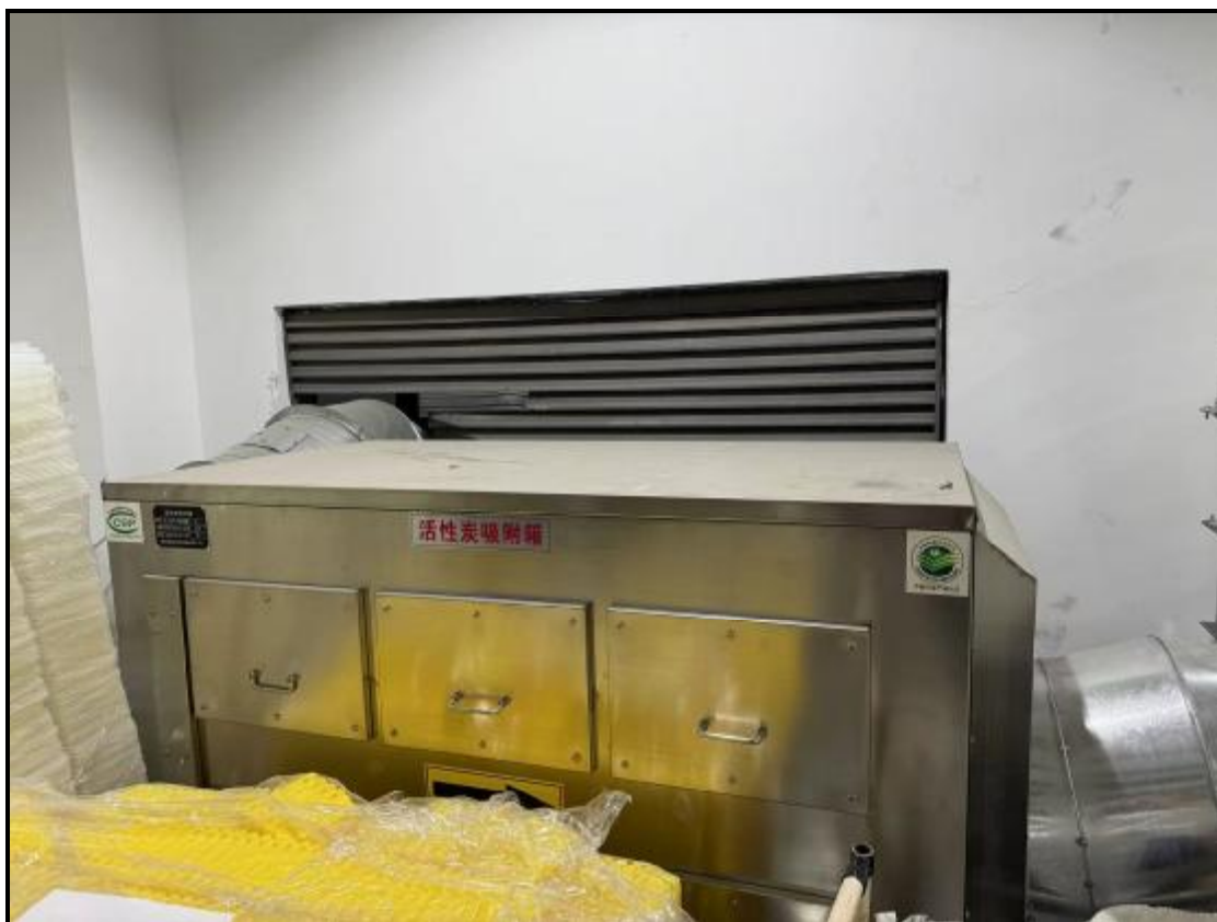
图 4-5 废气治理设施照片（活性炭吸附装置）
