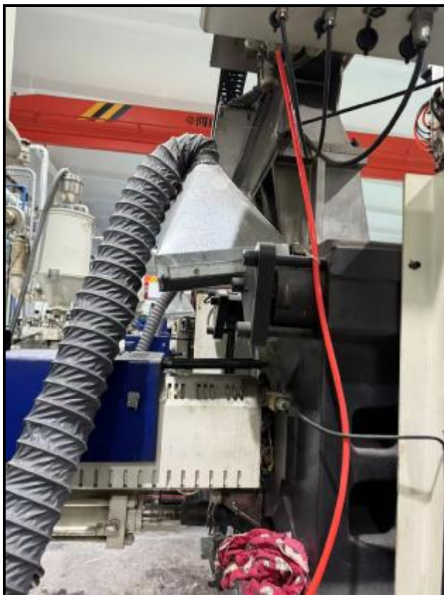
图 4-7 废气收集设施照片 2
