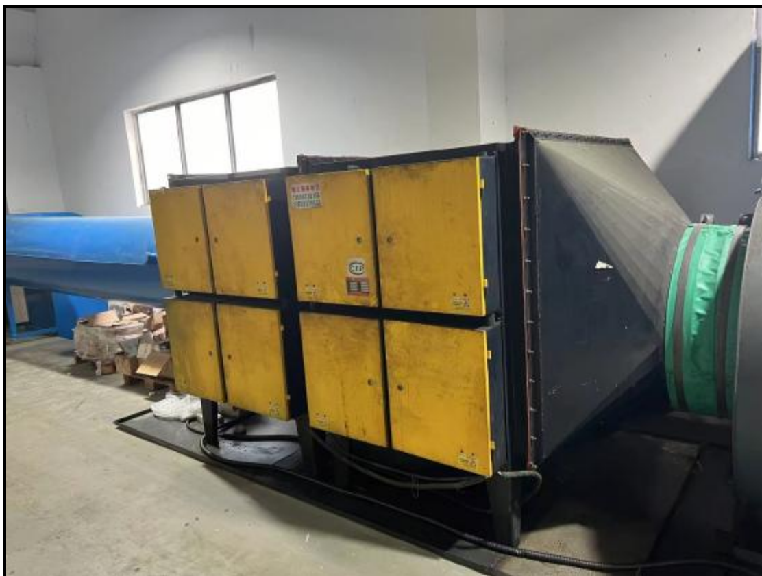
图 4-3 废气治理设施照片（静电除油装置（中部））
