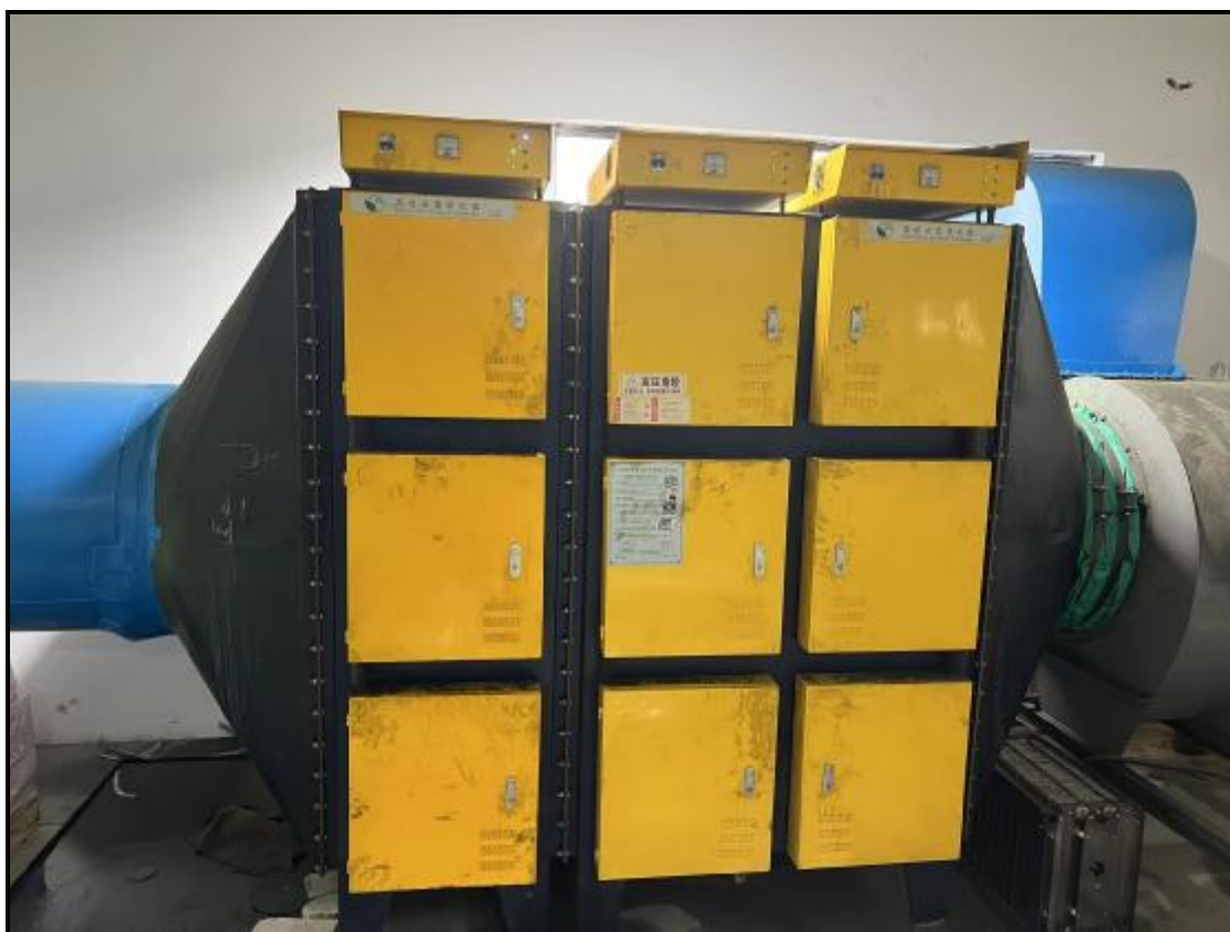
图 4-2 废气治理设施照片（静电除油装置（南侧））
