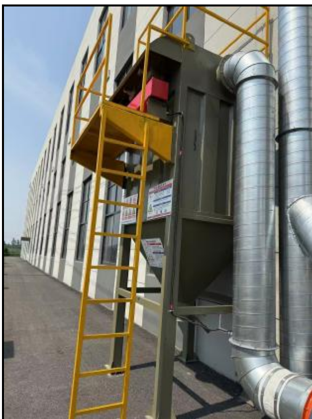
图 4-2 废气治理设施照片（人工焊接烟尘）
