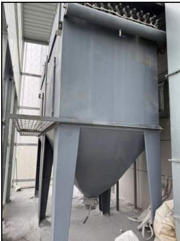
图 4-3 废气治理设施照片（喷砂粉尘 1）
