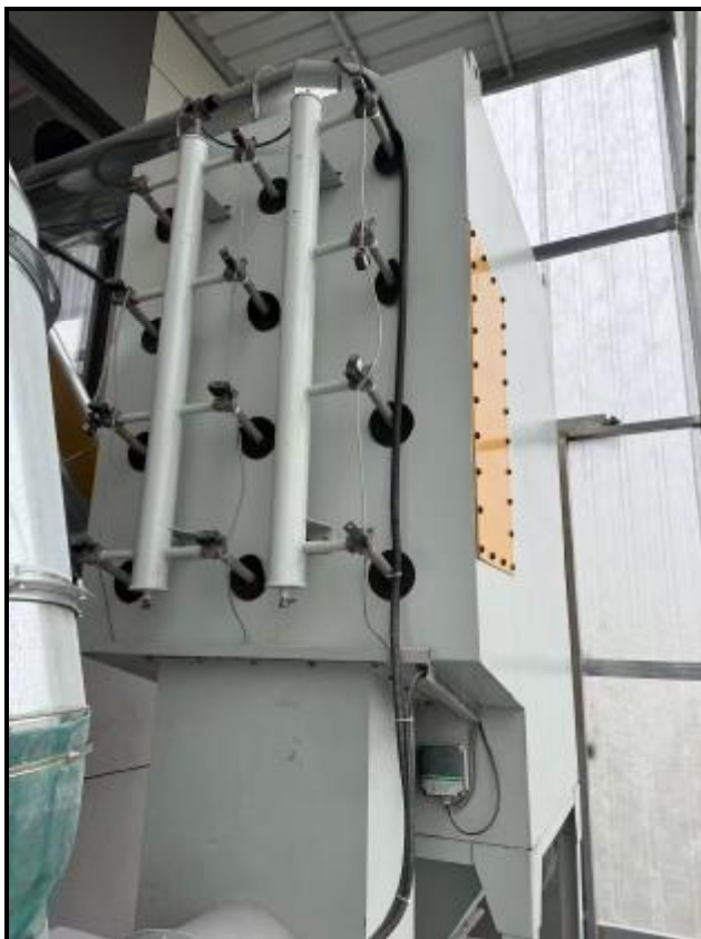
图 4-4 废气治理设施照片（喷砂粉尘 2）
