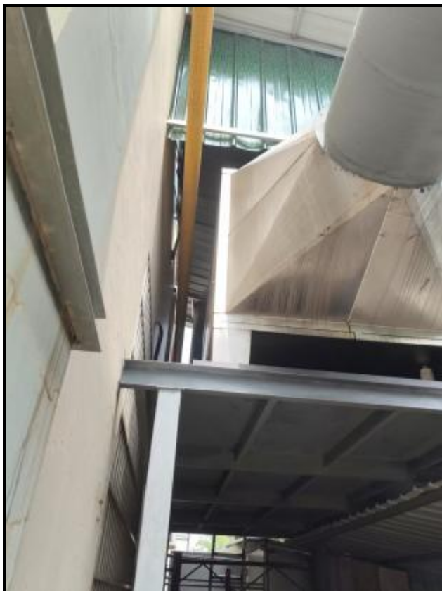
图 4-2 废气治理设施照片（冷镦、搓丝废气）
