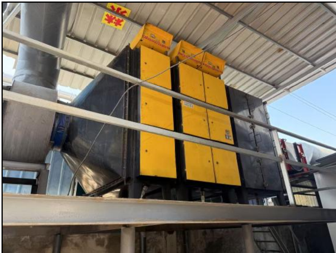
图 4-4 废气治理设施照片（淬火、回火、天然气燃烧废气）
