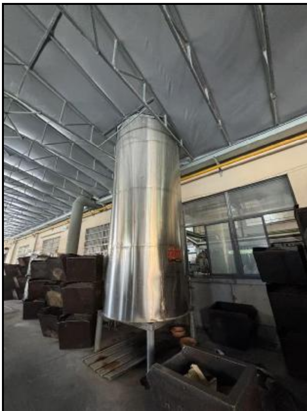
图 4-3 废气治理设施照片（加热天然气燃烧废气）
