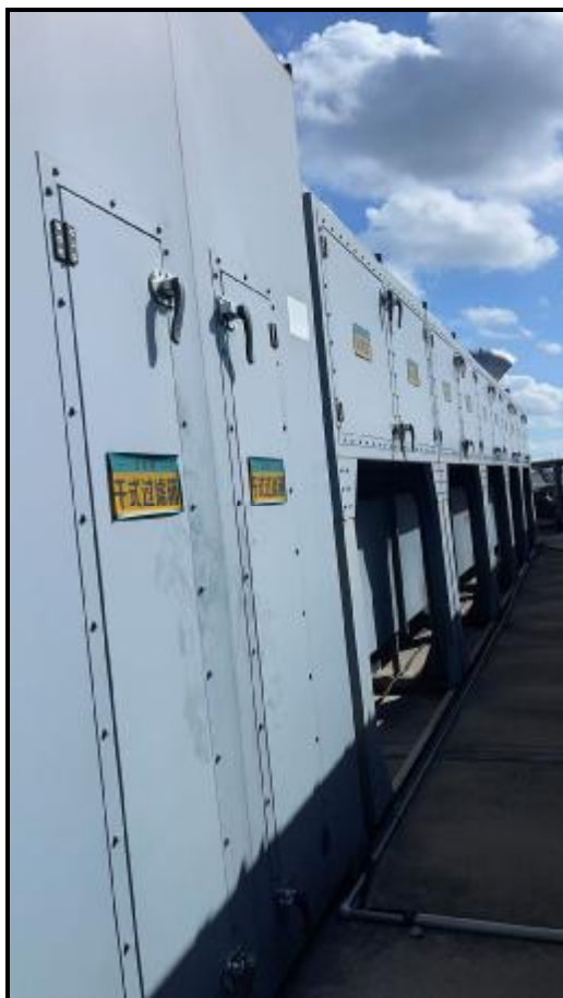
图 4-4 废气治理设施照片（喷涂、烧结、天然气燃烧废气）
