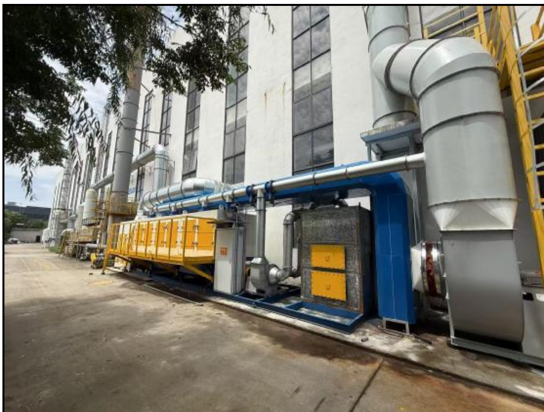
图 4-6 废气治理设施照片（北侧喷漆、晾干废气）
