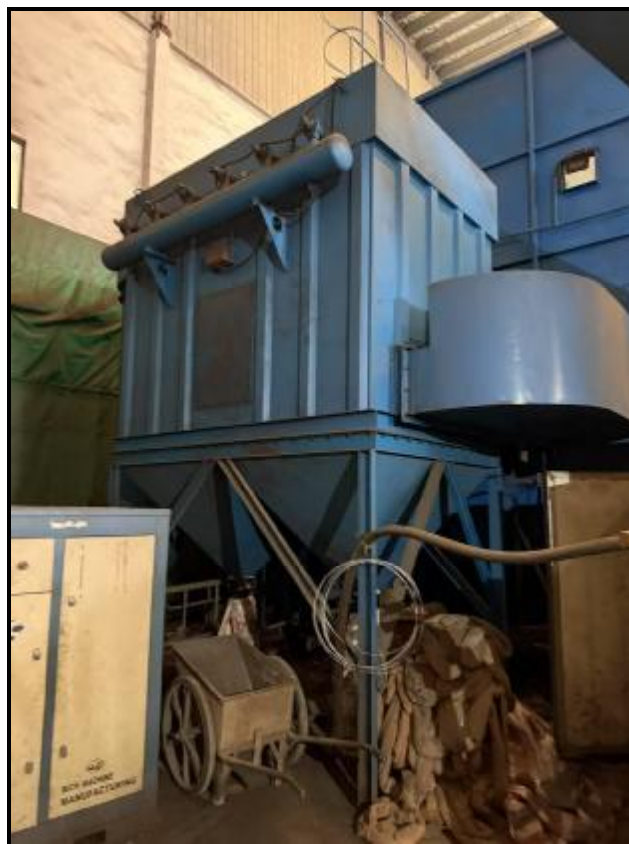
图 4-4 废气治理设施照片（喷砂粉尘）
