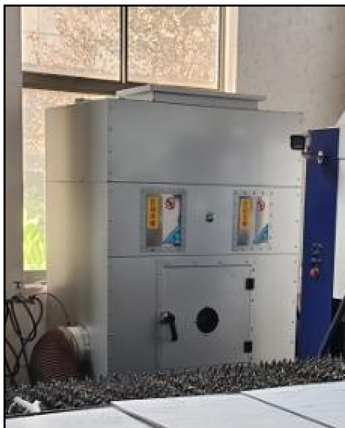
图 4-2 废气治理设施照片（激光切割烟尘）
