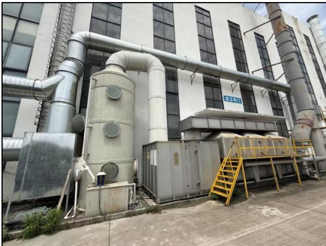
图 4-5 废气治理设施照片（南侧喷漆、晾干废气）
