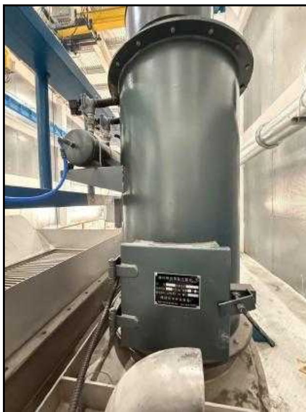
图 4-4 废气治理设施照片（投料粉尘）
