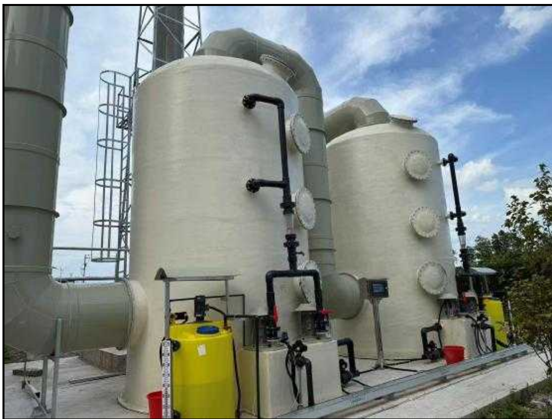
图 4-6 废气治理设施照片（污水站污泥浓缩压滤及污泥仓库废气）
