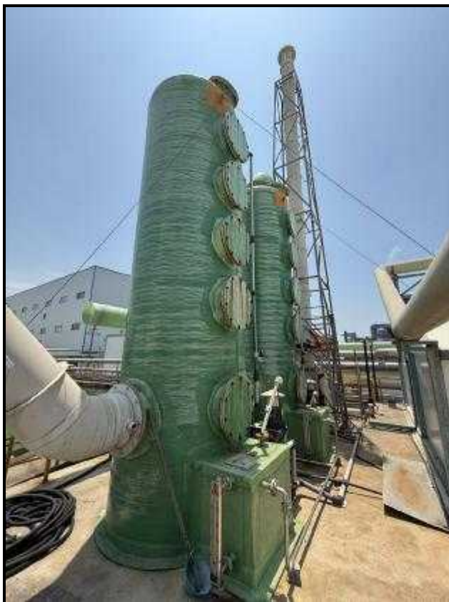
图 4-5 废气治理设施照片（污水站生化废气）
