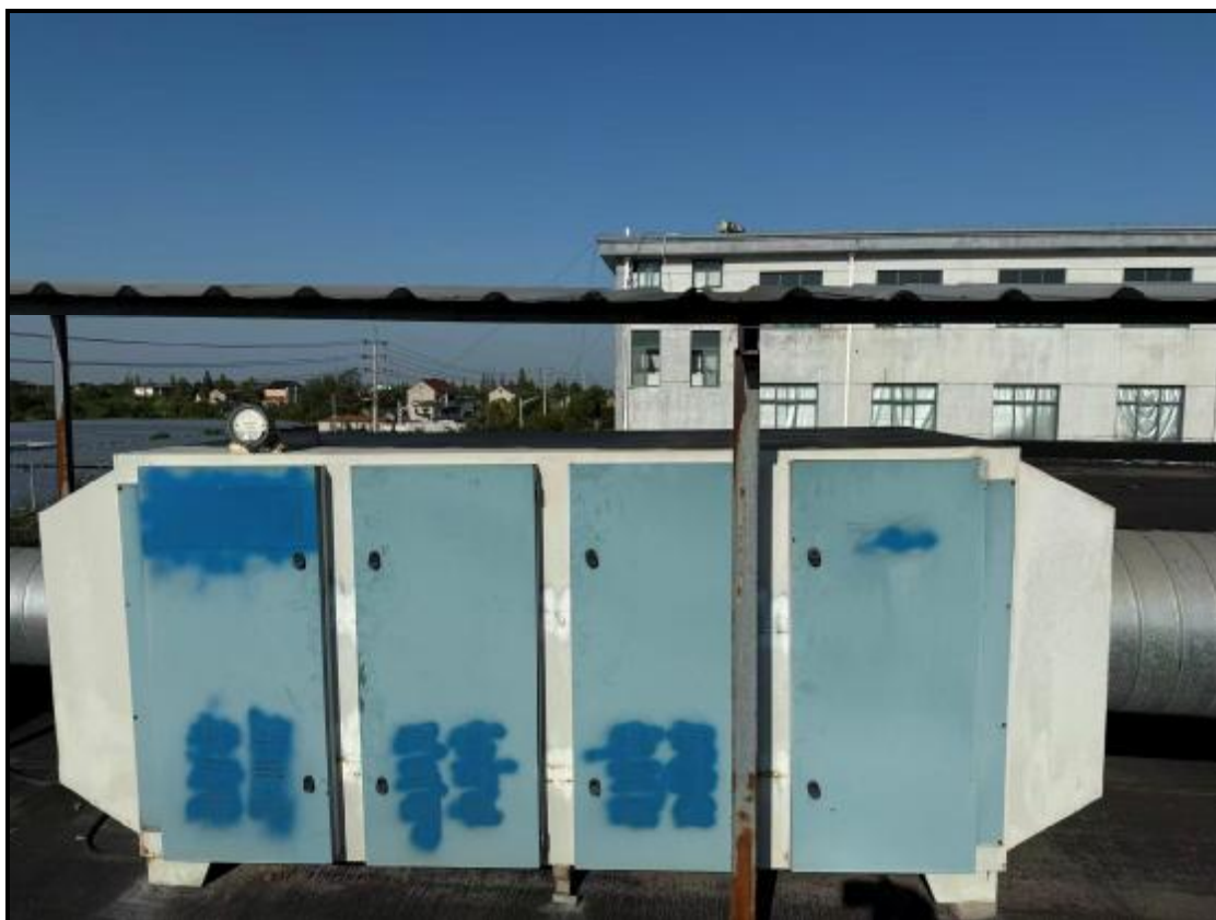
图 4-3 废气治理设施照片（西侧注塑废气）
