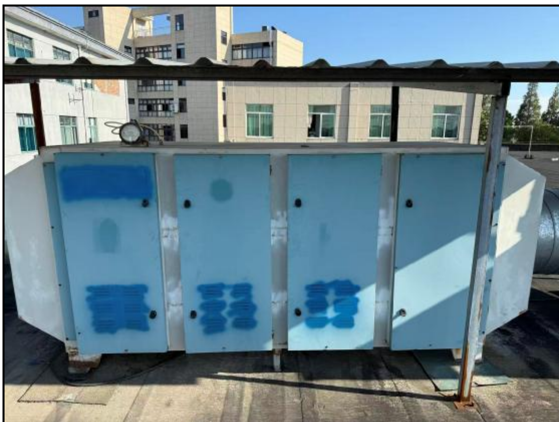
图 4-2 废气治理设施照片（东侧注塑废气）
