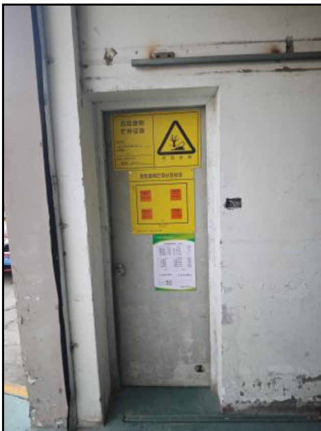
图 4-4 危废暂存场所照片（外部）
