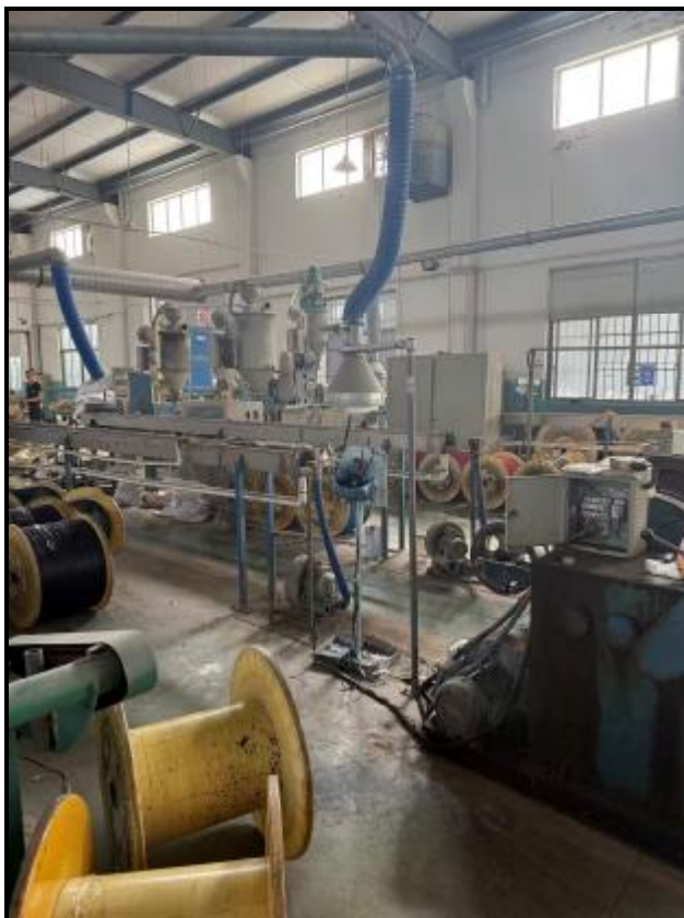
图 4-3 废气收集设施照片
