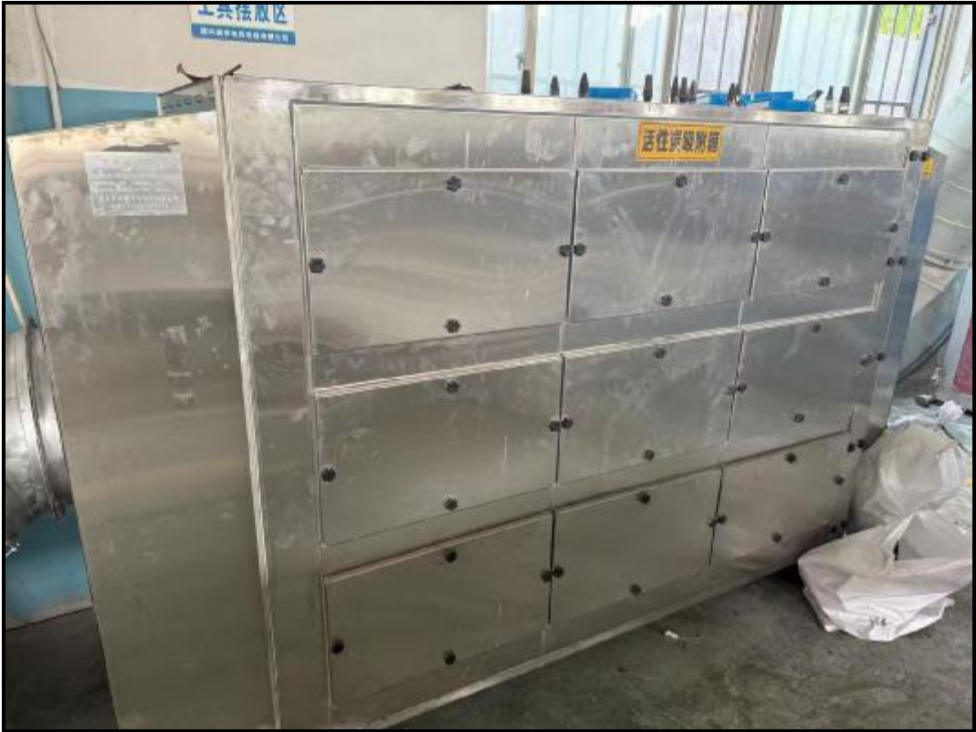
图 4-2 废气治理设施照片
