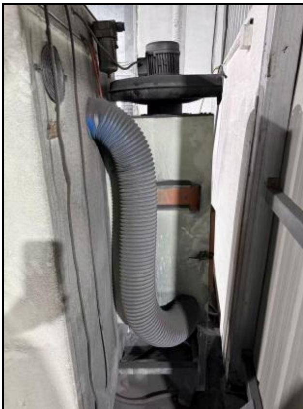
图 4-6 废气治理设施照片（布袋除尘装置 3）
