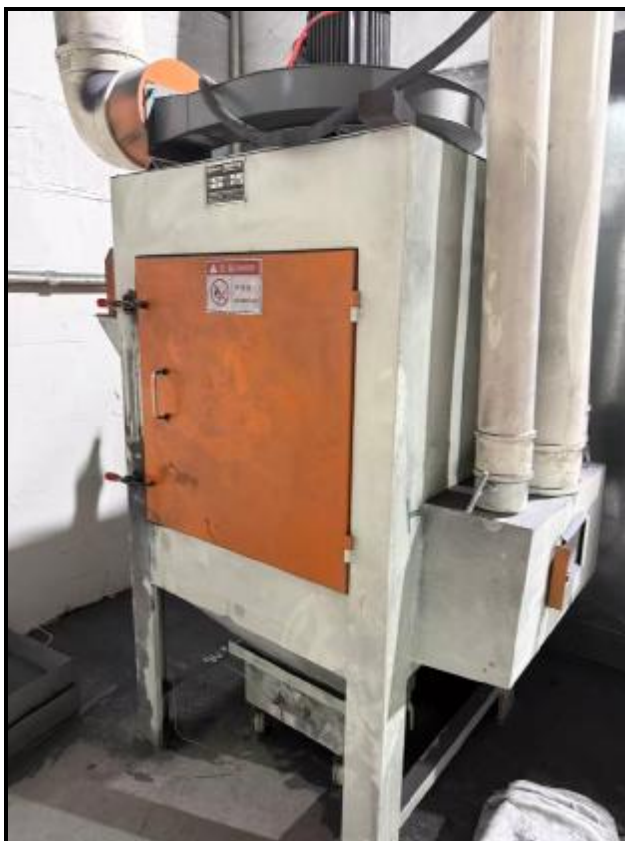
图 4-4 废气治理设施照片（布袋除尘装置 1）
