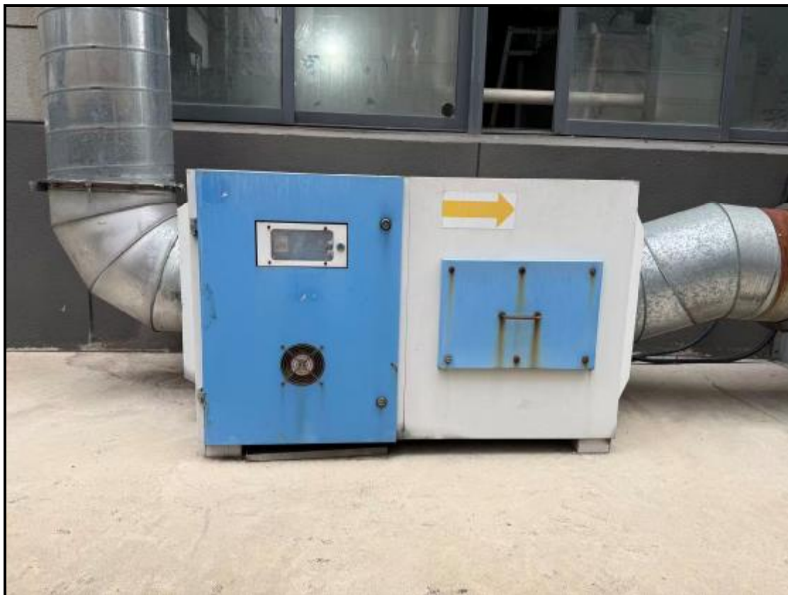
图 4-3 废气治理设施照片（静电除油+活性炭吸附装置）
