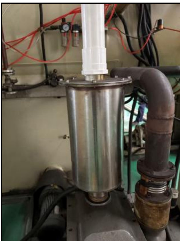
图 4-2 废气治理设施照片（油雾过滤器）
