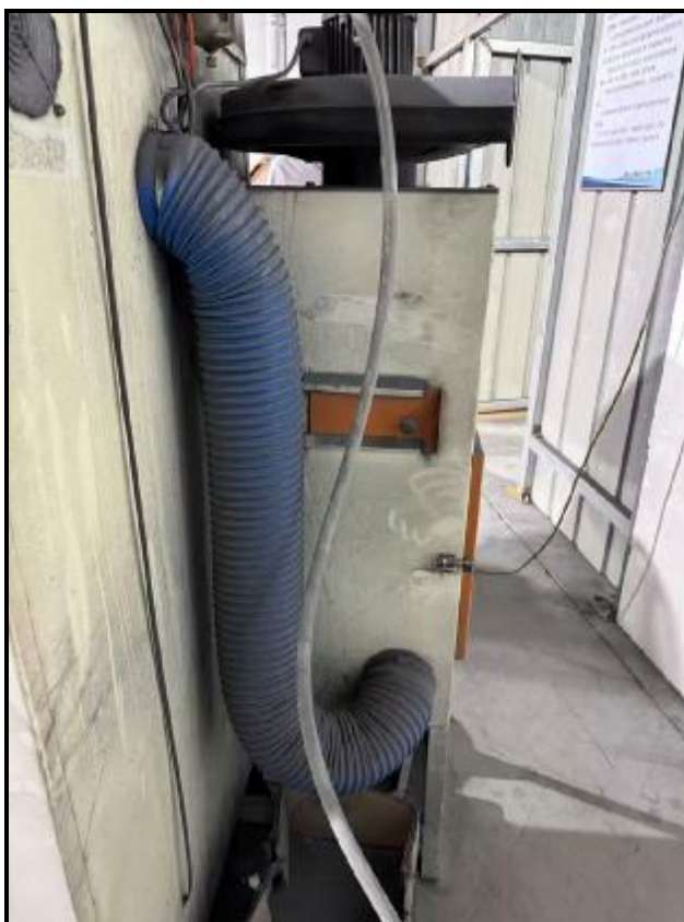
图 4-5 废气治理设施照片（布袋除尘装置 2）
