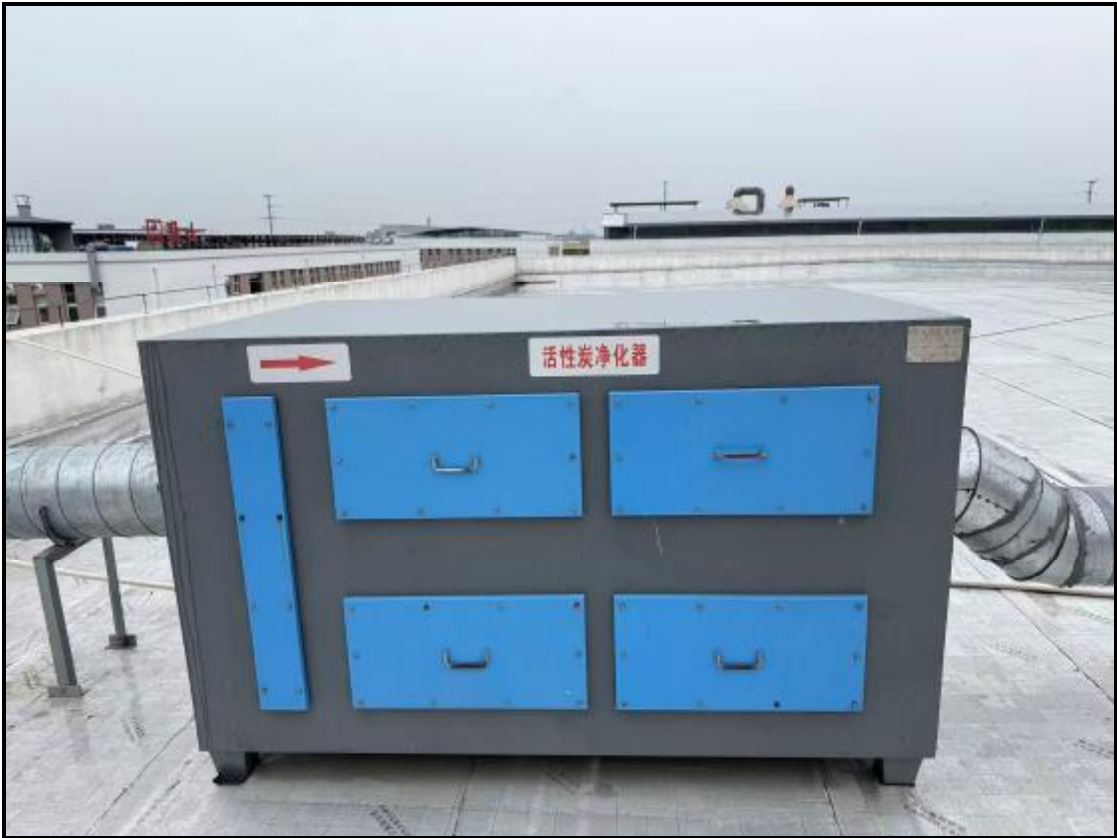
图 4-2 废气治理设施照片
